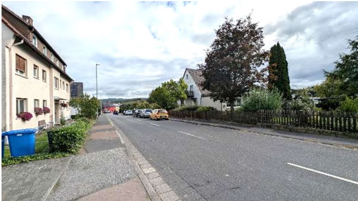
Bild A2 Blick in die Erschließungsstraße
