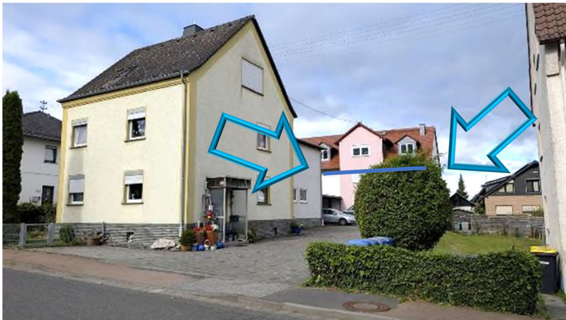
Bild B2 exemplarische Gebäudeansicht
