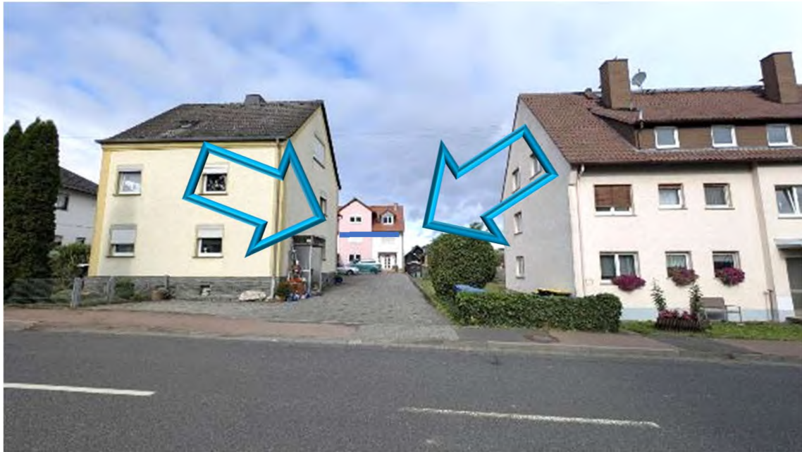
Bild B1 exemplarische Gebäudeansicht
