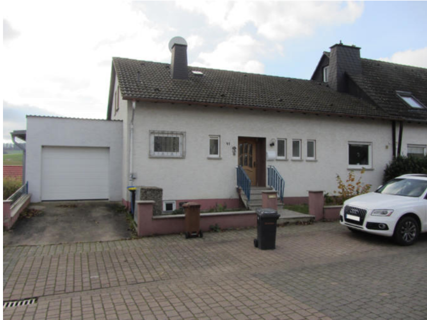
Bild 1: Längsseite des Bewertungsobjekts aus nördlicher Richtung
