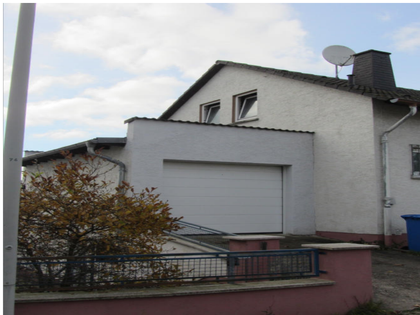
Bild 2: Giebelseite des Bewertungsobjekts aus nordöstlicher Richtung
