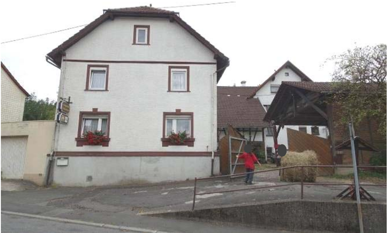
Foto 1: Anwesen Flst. 207/1; Ansicht von der Oberstraße (Straßenansicht/Nordost-Ansicht)
