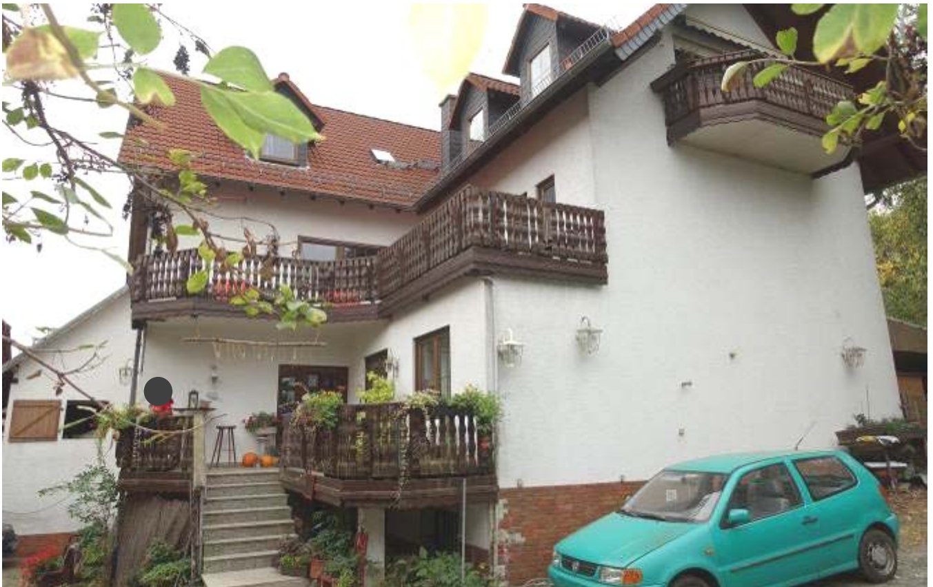
Foto 2: Gaststättengebäude, Eingangsseite; Ansicht von Nordwesten
