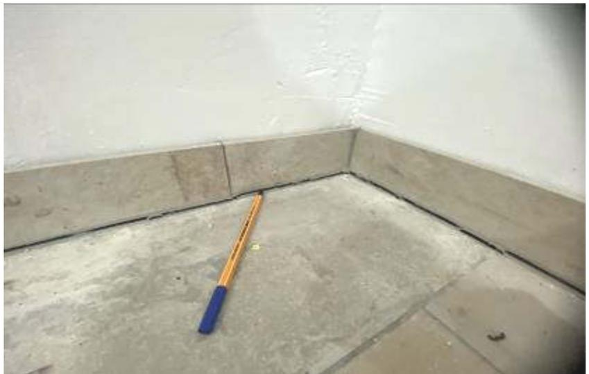
**Abb. 11:** Foto des SV; z.T. Anschlussfuge zur Sockelleiste z.T. offen, KG
