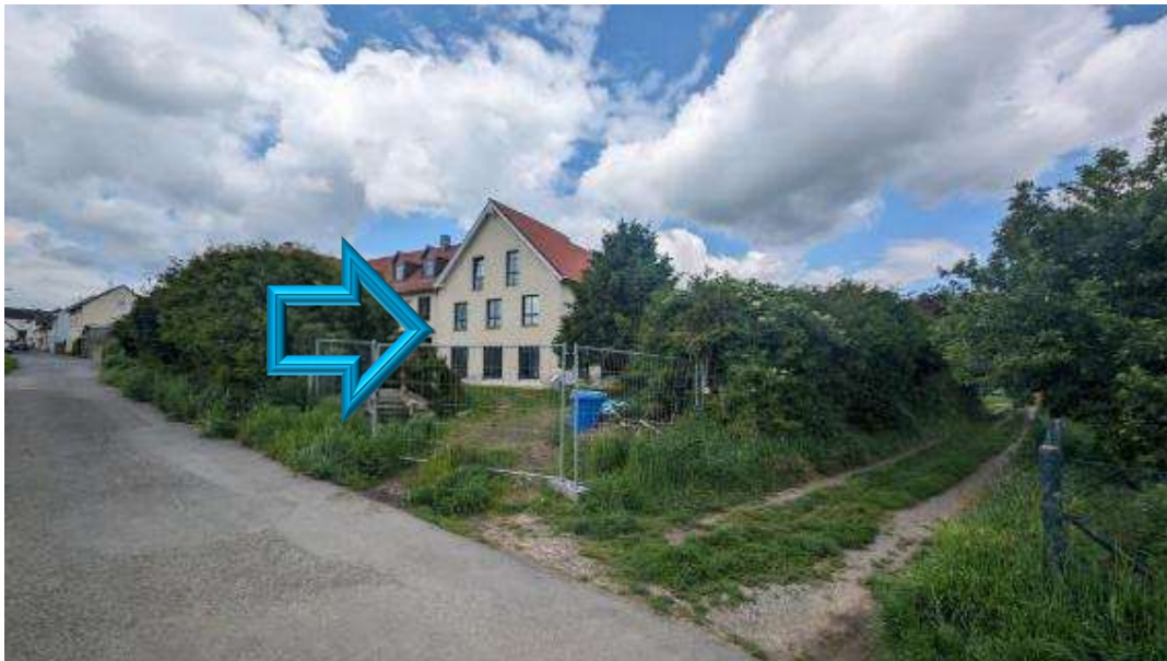
Bild B2 Gesamtansicht – Blick von Südosten
