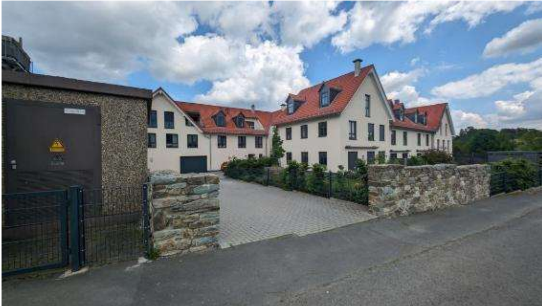
Bild B1 Gesamtansicht – Blick von Südwesten mit Blick auf die Garage
