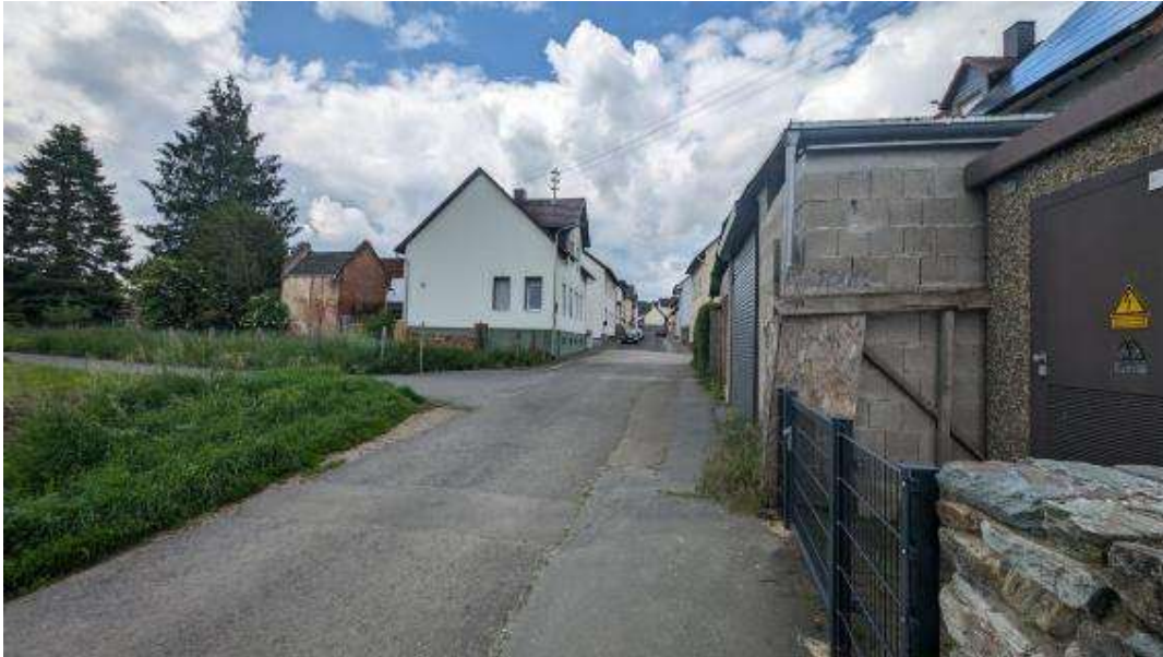
Bild A1 Blick in die Erschließungsstraße
