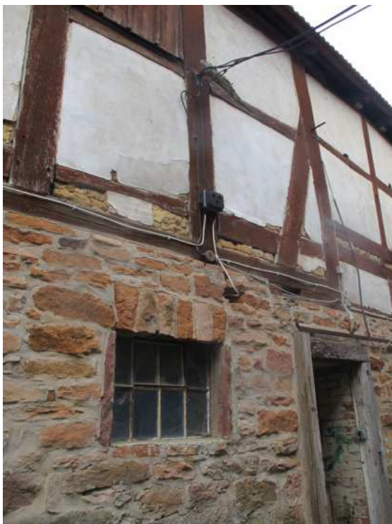
Sanierungsbedarf Fachwerkfassade
