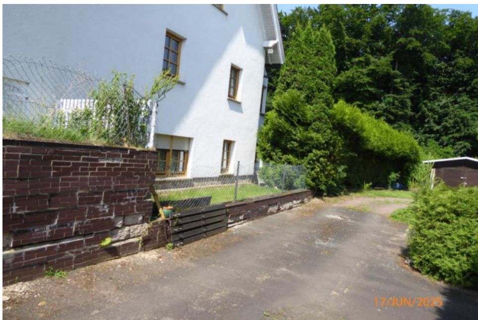
Foto 12: beschädigte Stützmauer entlang der nordöstlichen Grundstücksgrenze
