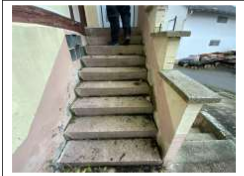
Abb.: Eingangstreppe zum Erdgeschoss
