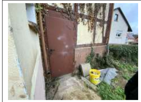
Abb.: Zugang Kellergeschoss
