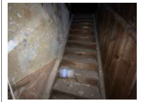
Abb.: Treppe OG-DG
