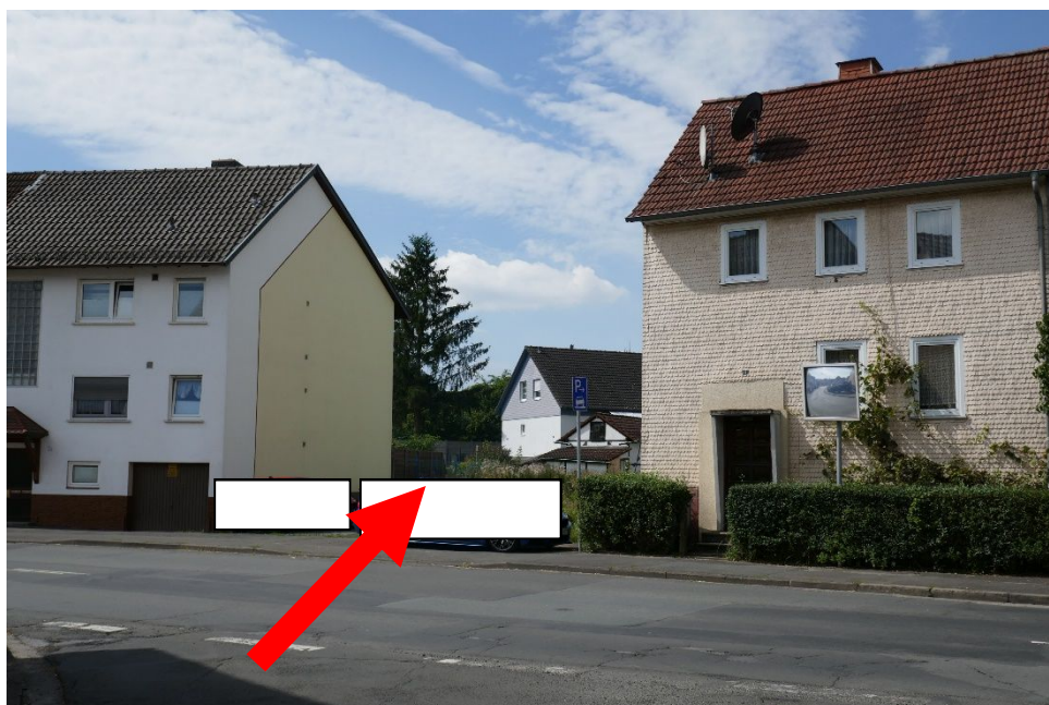
Bild_10_“Lehmkaute 7a (links); Bauplatz; und Lehmkaute 11 (rechts)“
