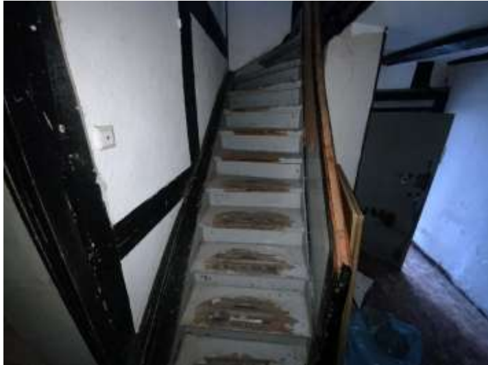
Bild 16: Treppe EG - KG
