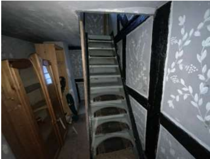
Bild 22: Treppe 1. OG - 2. OG
