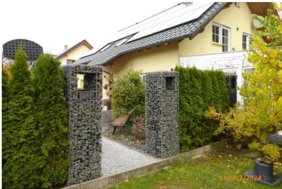
Foto 8: Ansicht aus südlicher Richtung
