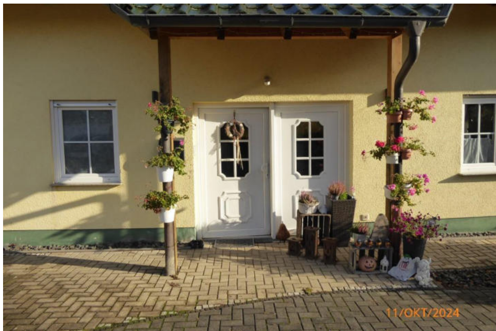
Foto 2: Ansicht des Hauseingangsbereich
