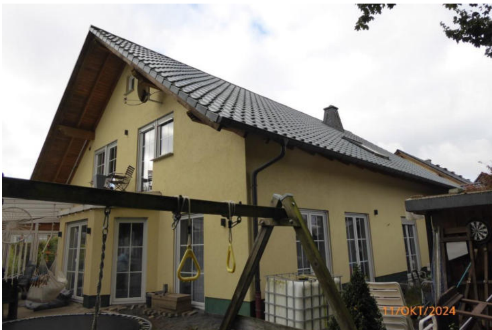
Foto 6: Gartenansicht aus nordöstlicher Richtung
