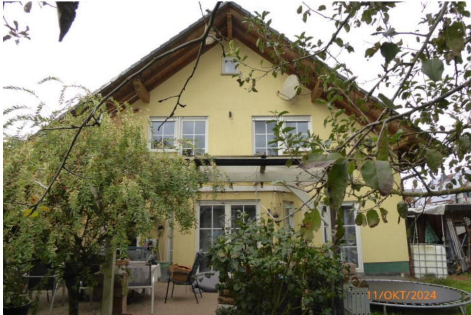
Foto 7: Ansicht aus südöstlicher Richtung
