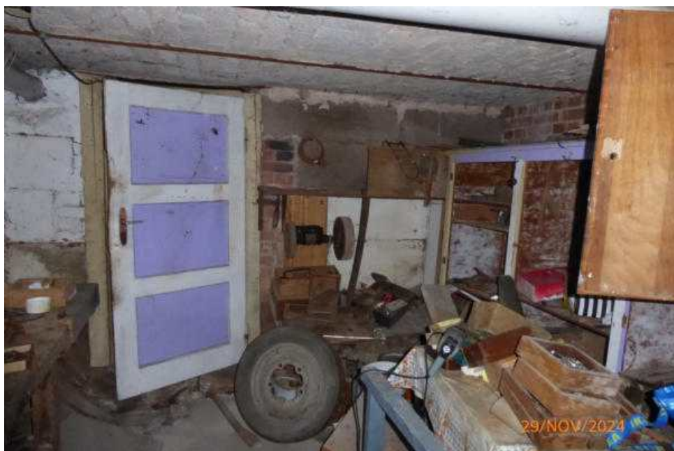
Foto 11: Kellerraum im Wohnhaus
