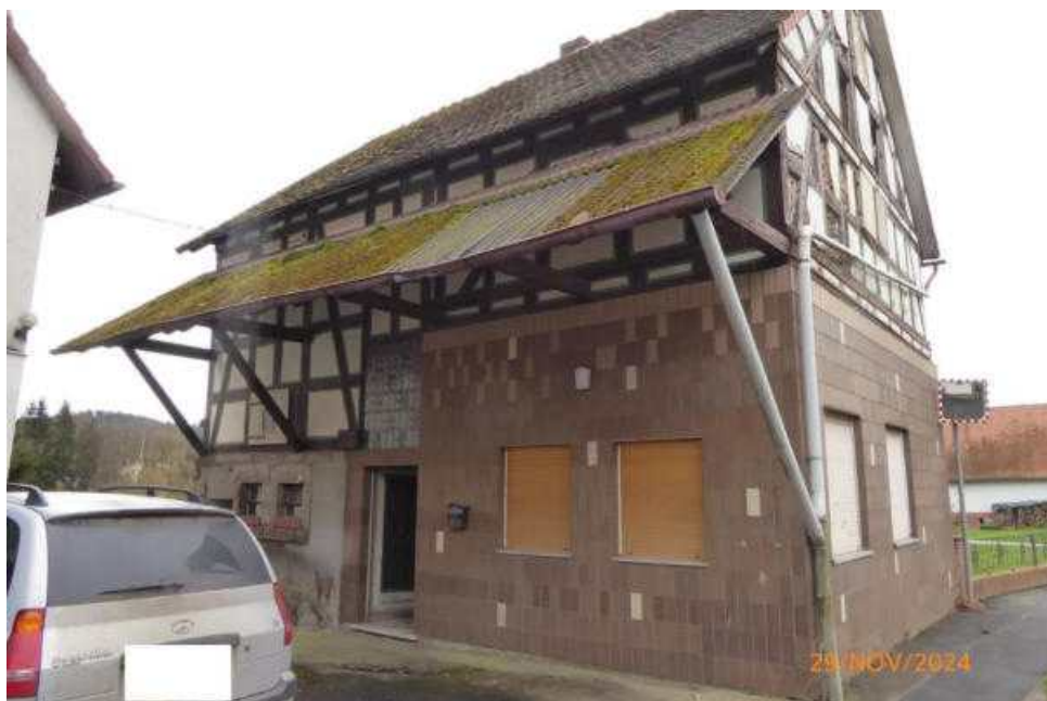
Foto 13: Hofansicht des Wirtschaftsgebäudes
