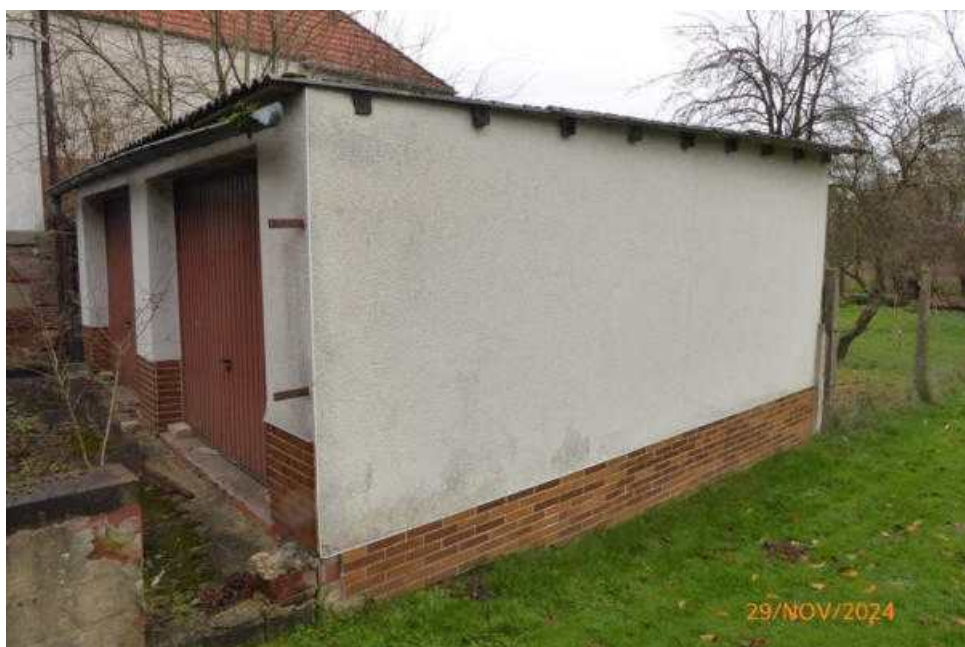
Foto 20: Ansicht der Garage aus südwestlicher Richtung
