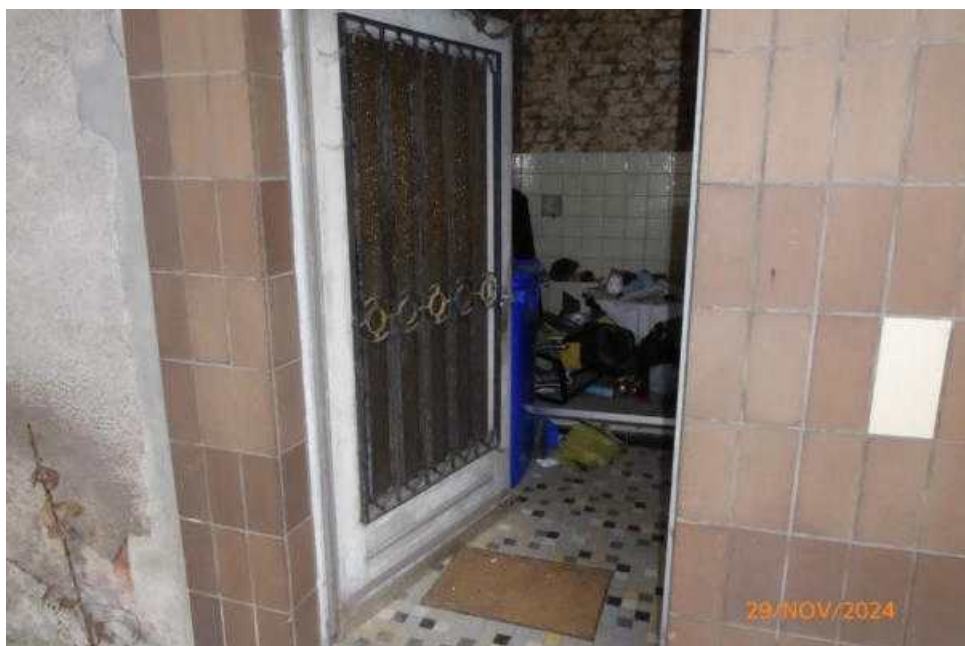
Foto 15: Ansicht des Eingangsbereichs zur ehemaligen Poststelle
