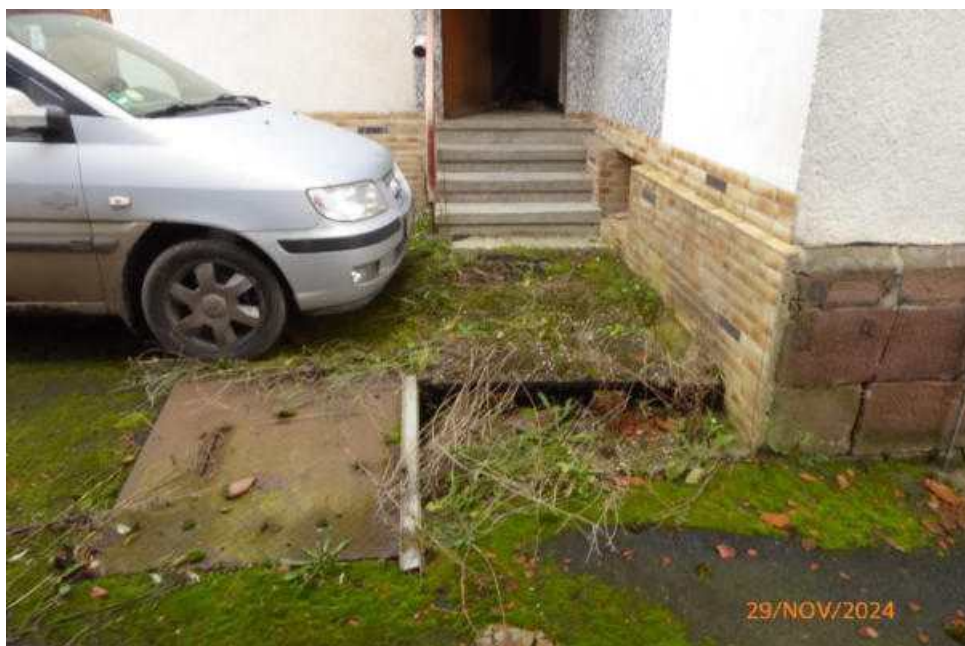
Foto 3: Ansicht des Hauseingangsbereichs
