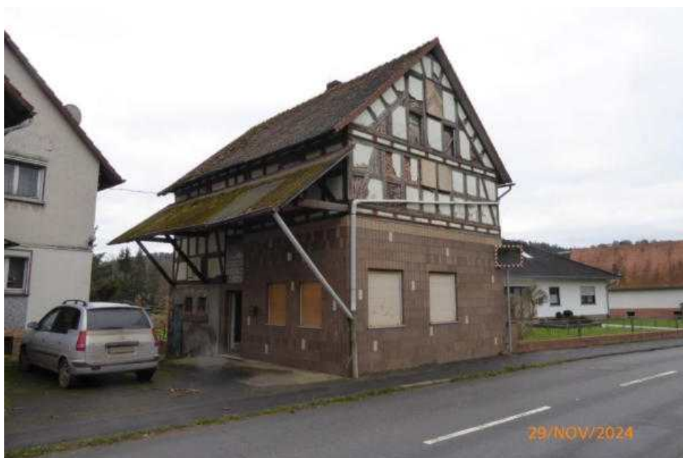
Foto 12: Straßenansicht des Wirtschaftsgebäudes
