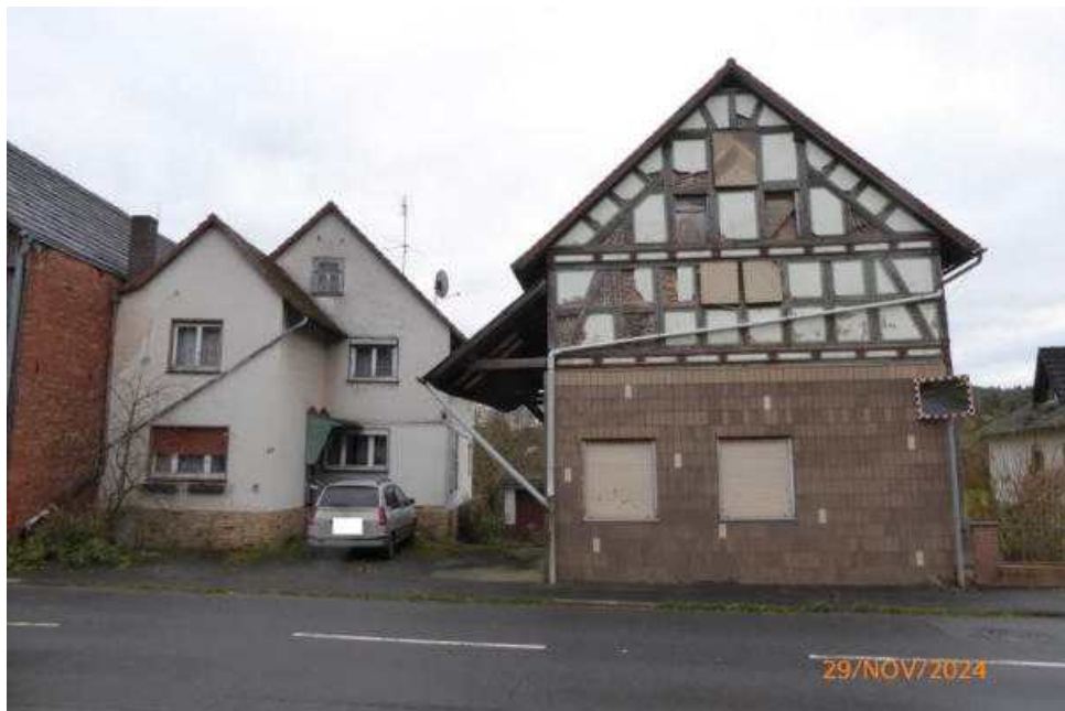
Foto 1: Straßenansicht der Hofanlage
