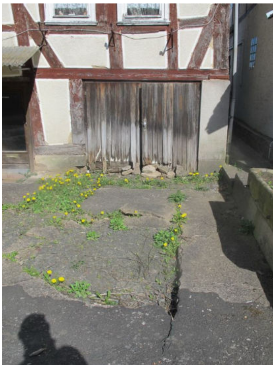
straßenseitige Freifläche Nr. 20
