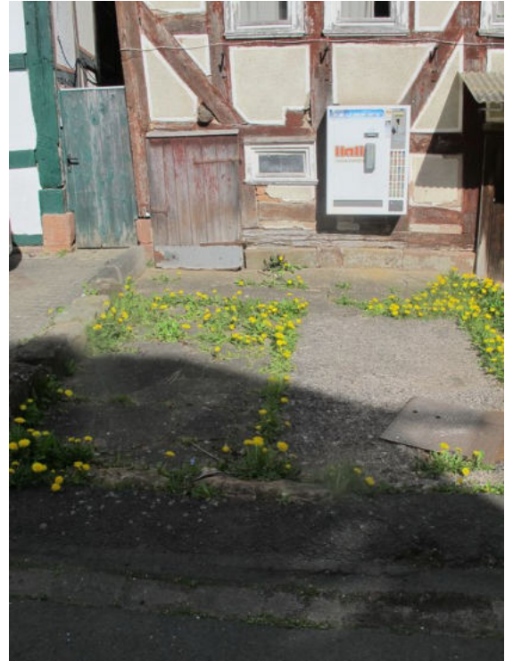
straßenseitige Freifläche Nr. 22
