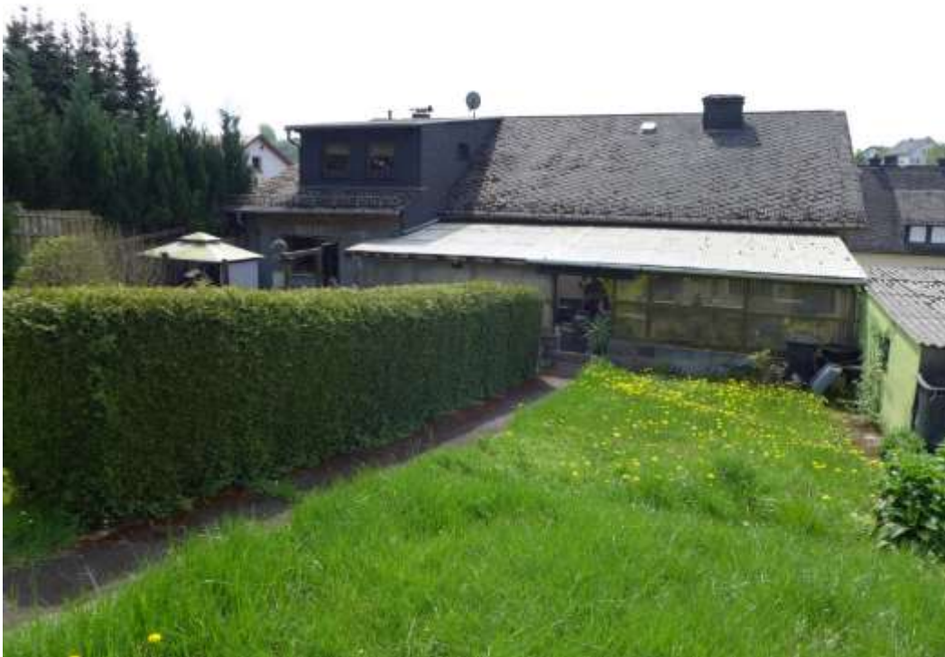
7 Gebäude-Rückansicht (Nordostansicht), Garten
