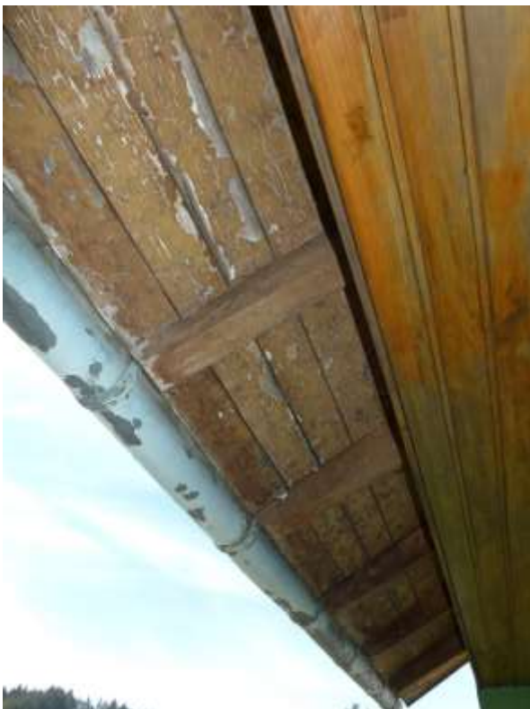
26 a Zustand Dachrand
