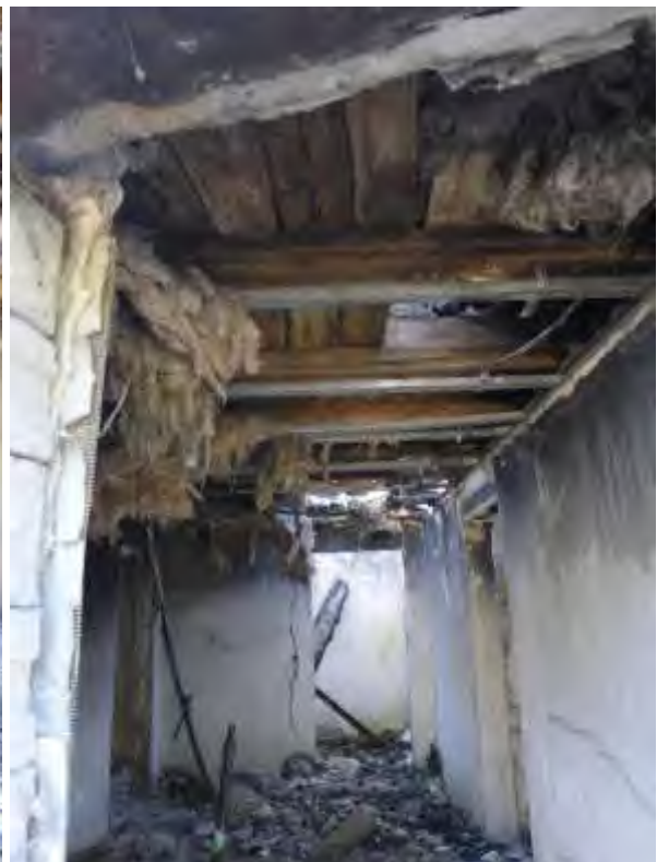
18 b Zustand Deckenkonstruktion
