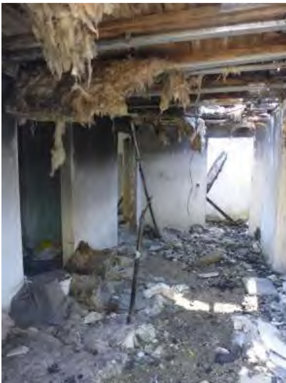
18 a Eingangsbereich (Obergeschoss)
