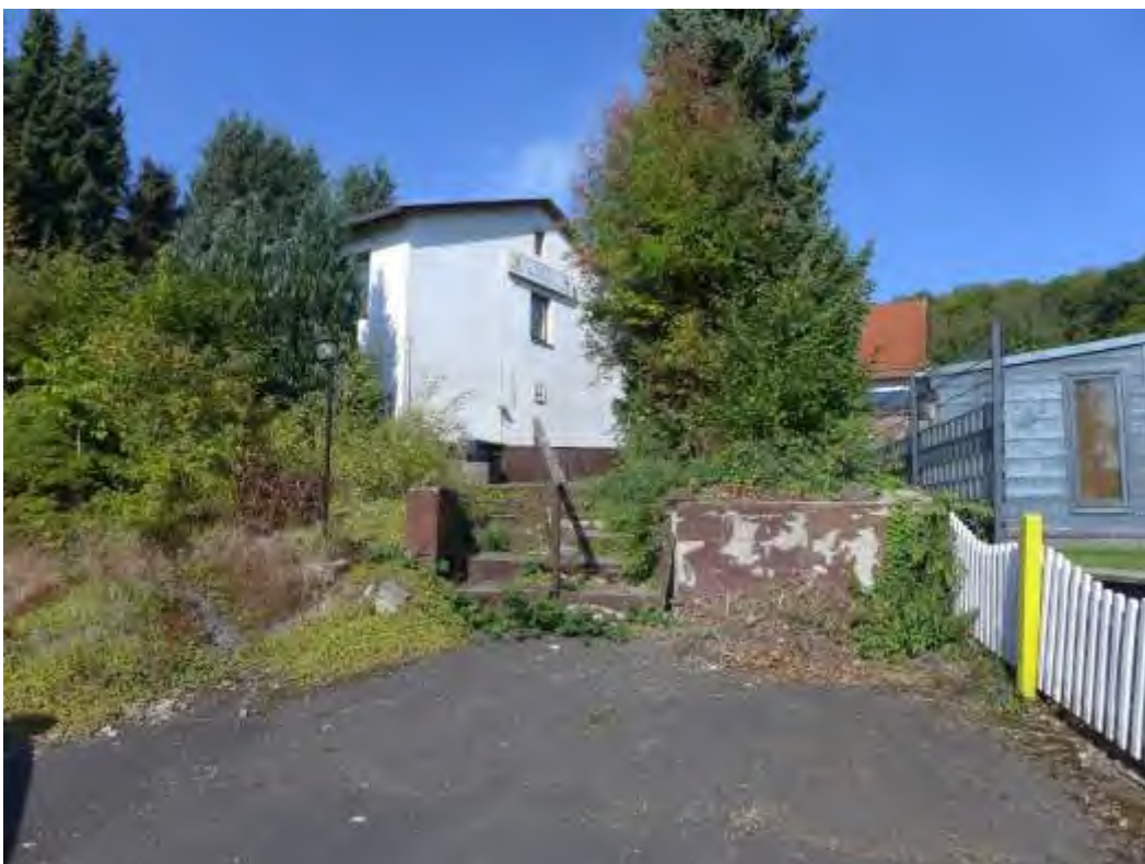
16 Bereich Baulastenfläche zum Nachbargebäude Hausnummer 1
