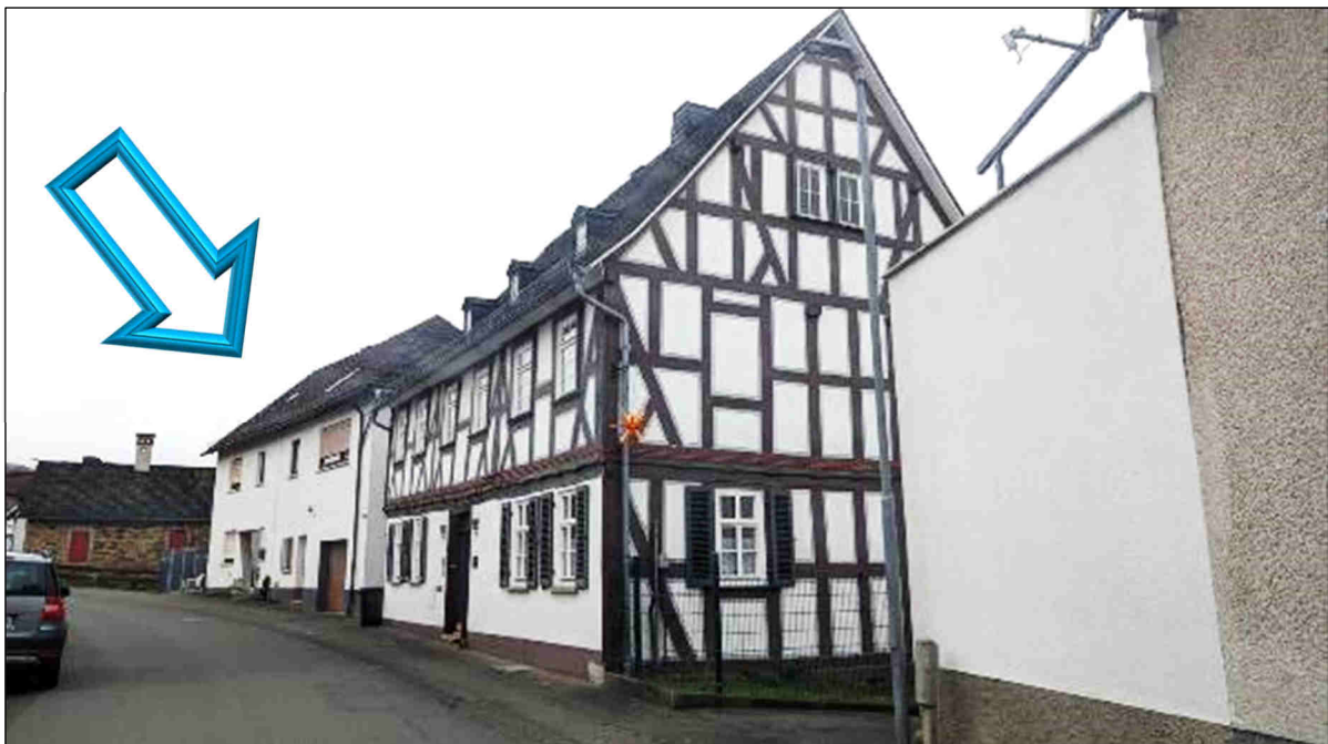
Bild A2: Ansicht Wohnhaus
