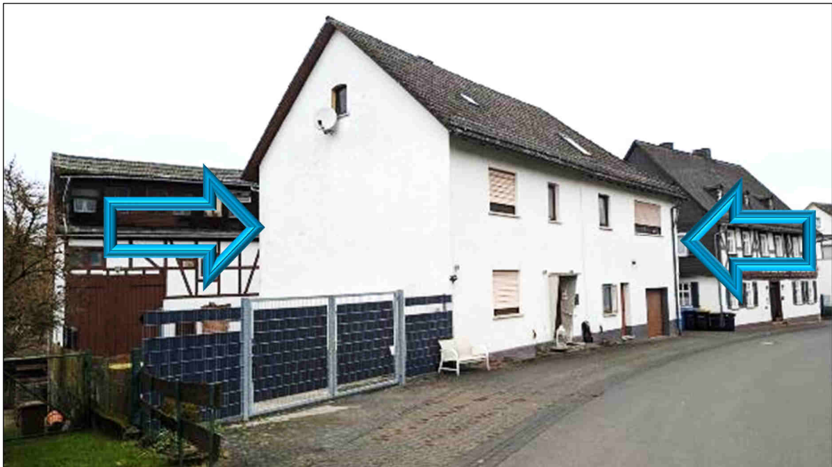
Bild A1: Ansicht Wohnhaus
