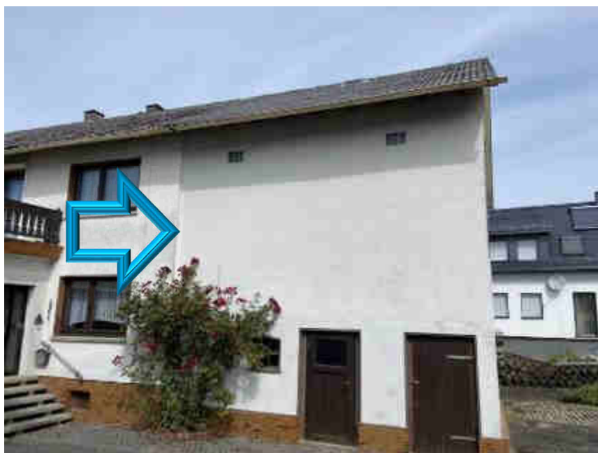
Bild B4 exemplarische Außenansicht Scheune
