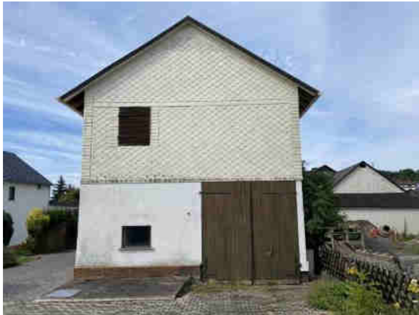
Bild B5 exemplarische Außenansicht Scheune
