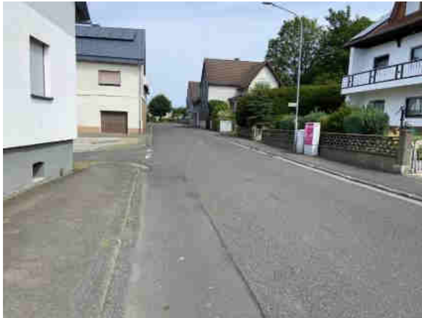
Bild A1 Blick in die Erschließungsstraße
