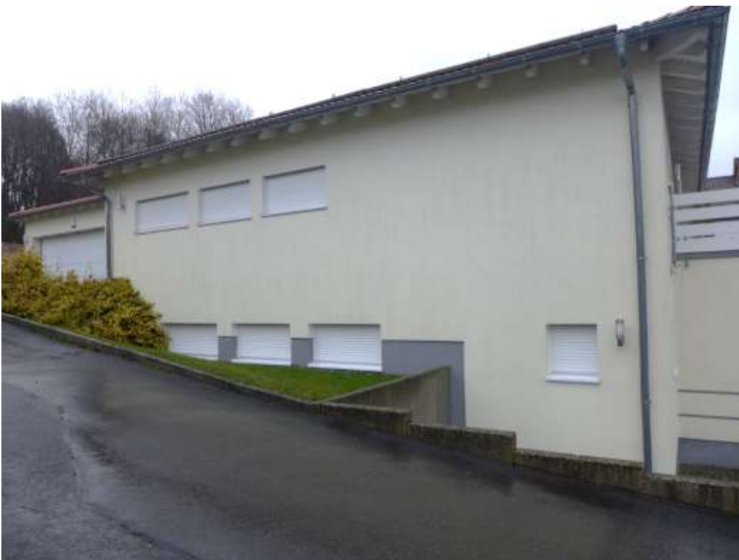
4 Seitenansicht oberer Gebäudeteil
