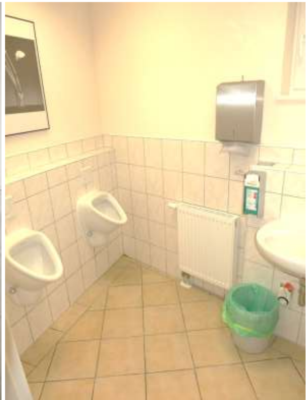
25 b Toiletten Erdgeschoss
