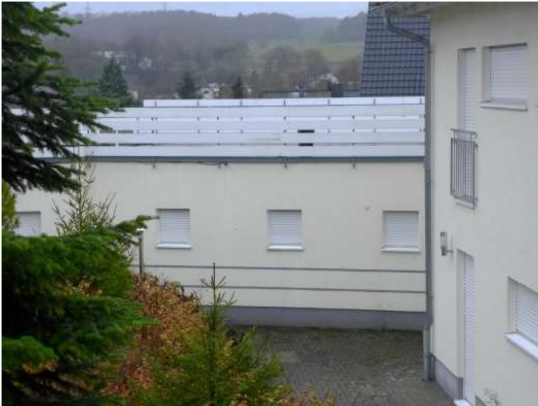
9 Rückseite des südlichen Gebäudeteils
