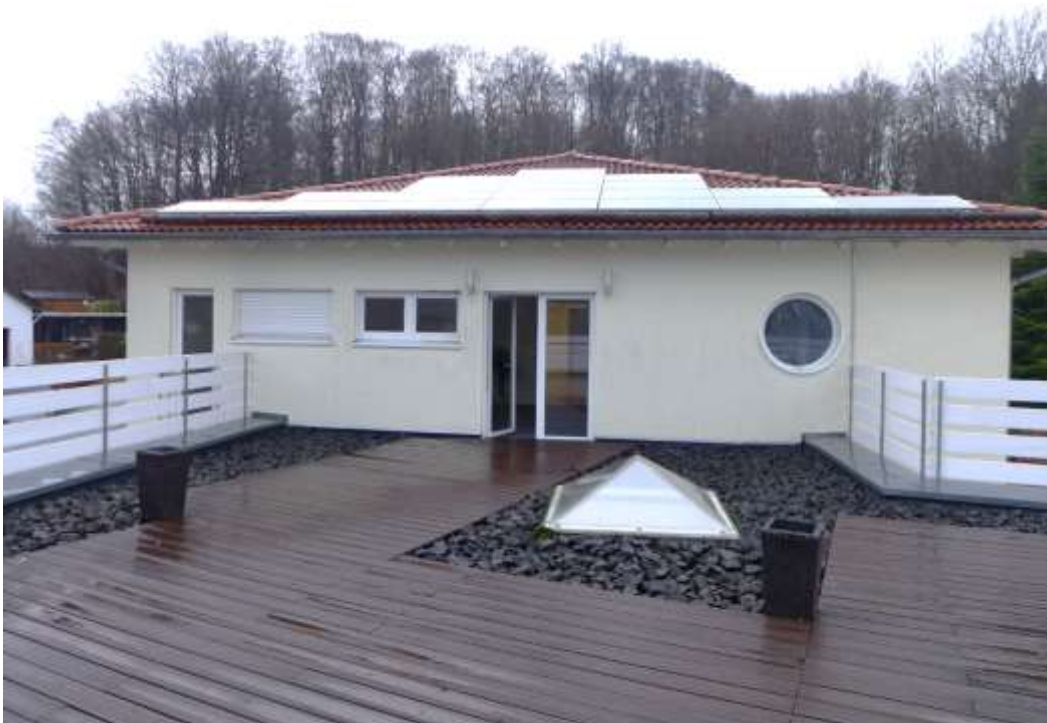
10 Ansicht Seminarraum (Obergeschoss)
