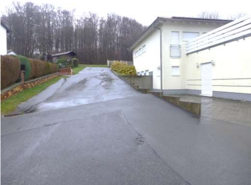
3 Stichweg Richtung Norden, oberer Gebäudeteil, Seitenansicht
