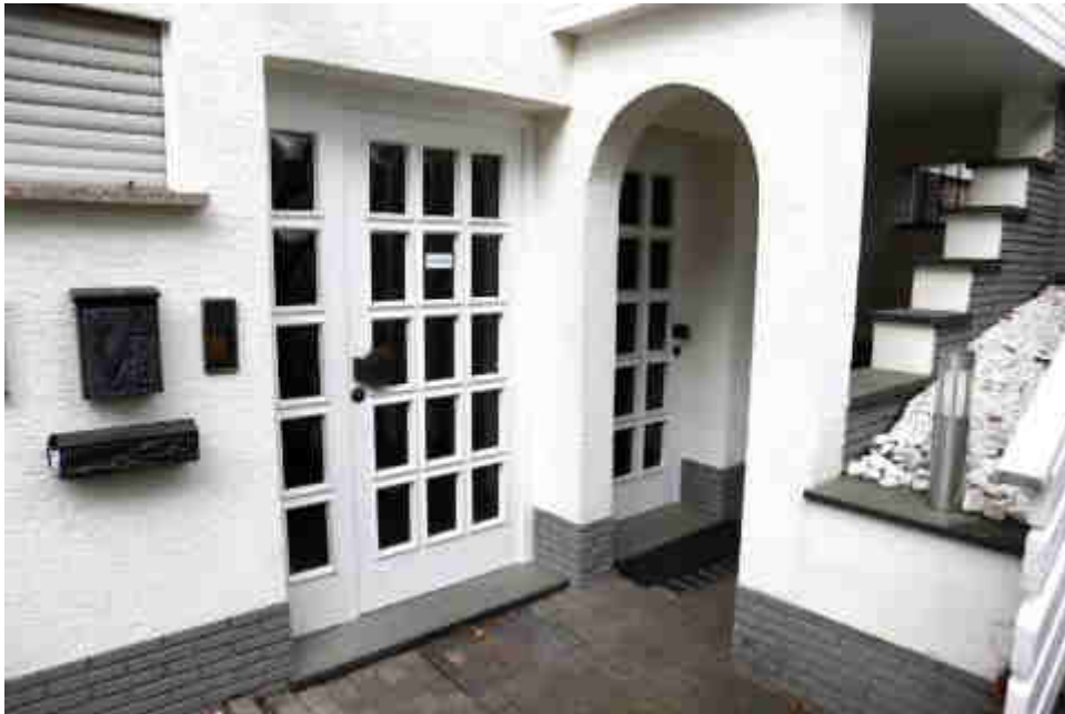
Bild B5 Eingangsbereich Teileigentum Nr. I
