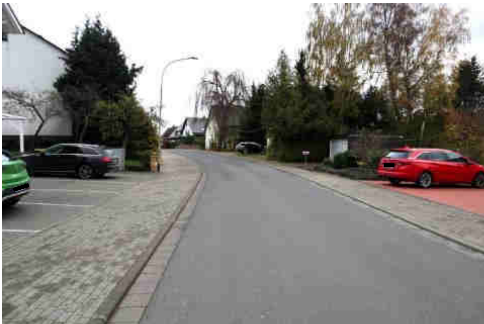
Bild A2 Blick in die Erschließungsstraße
