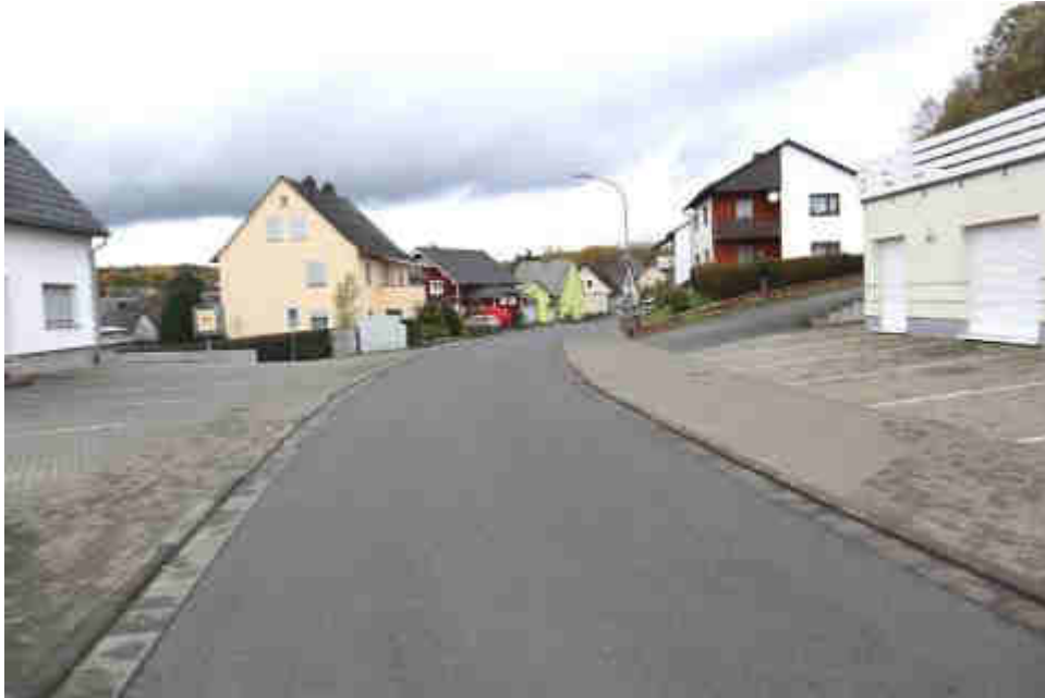
Bild A1 Blick in die Erschließungsstraße
