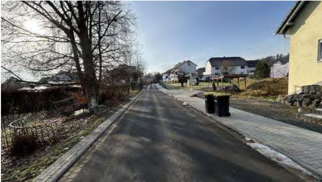
Bild A3 Blick in die Straße „Am Lockenbachsgraben“
