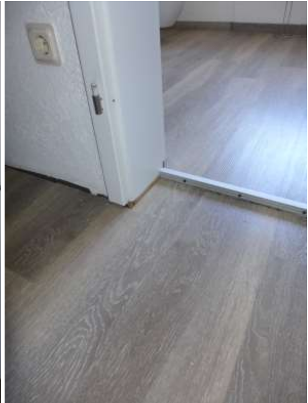
35 b unebener Fußboden mit Stolperschiene
