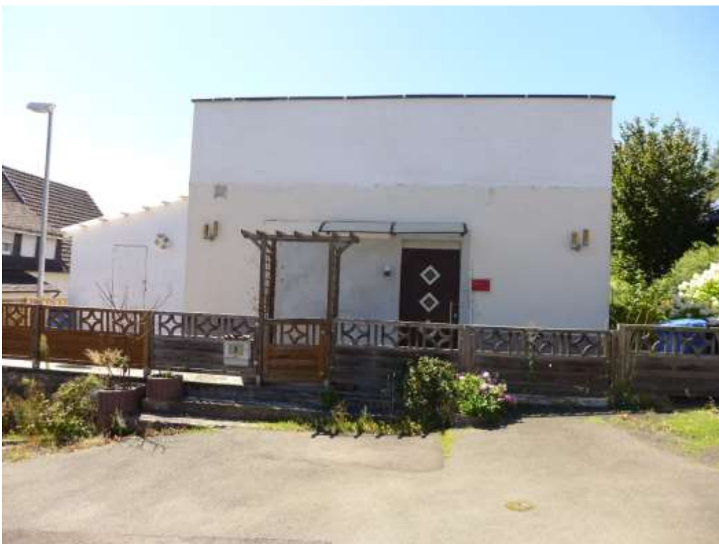
16 Ostansicht, Eingang Hauptwohnung
