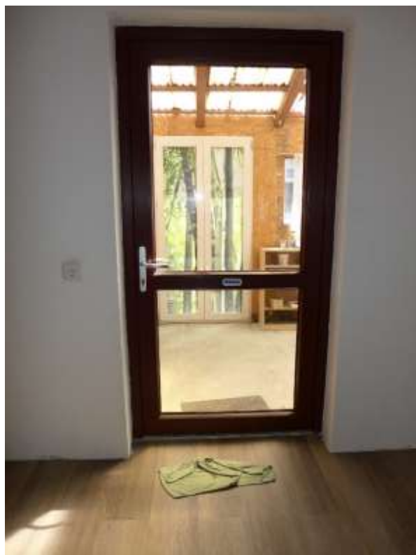
22 a Tür zur Terrasse
