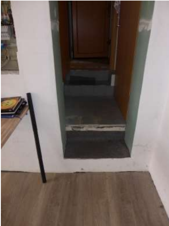
39 a Durchgang zur Einliegerwohnung EG
