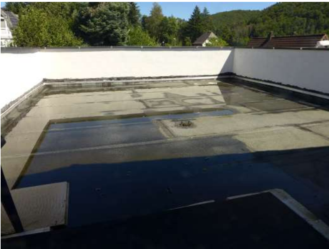
34 Dachabdichtung (Terrassenvorbereitung) Anbau
