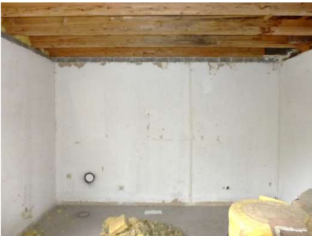
20 Zimmer OG im Anbau mit offener Decke
