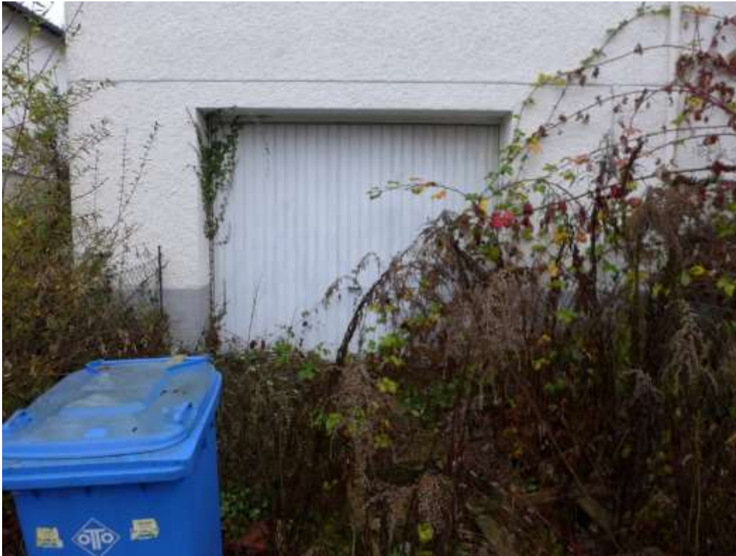
5 Garage im Kellergeschoss
