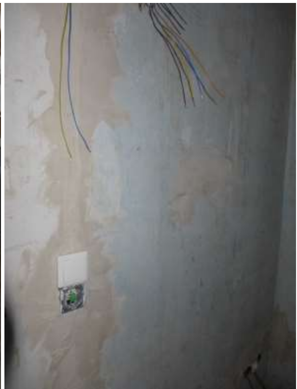
28 a nicht fachgerecht hergestellte Gipskartonverkleidung bzw. Wandputz
