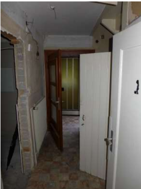
30 a Flur Erdgeschoss
