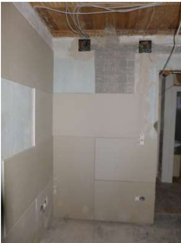
28 a nicht fachgerecht hergestellte Gipskartonverkleidung bzw. Wandputz
