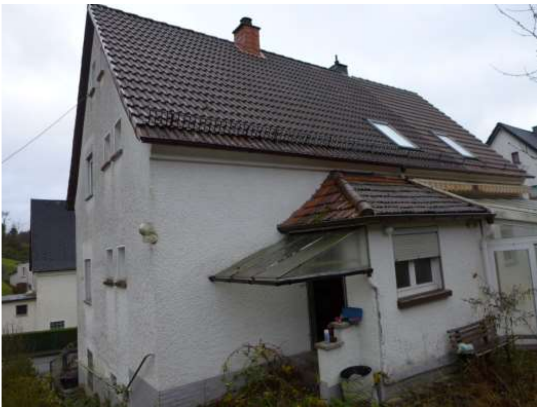
8 Rück-/Seitenansicht (Westansicht), Eingangsvorbau
