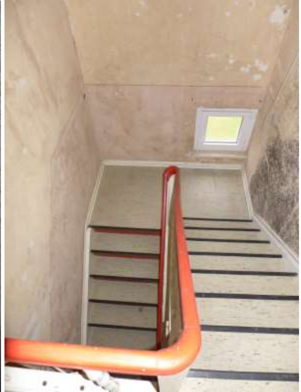
17 b Treppe zum Dachgeschoss
