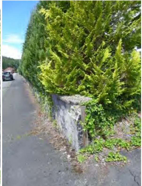
13 b Zustand Einfriedung
