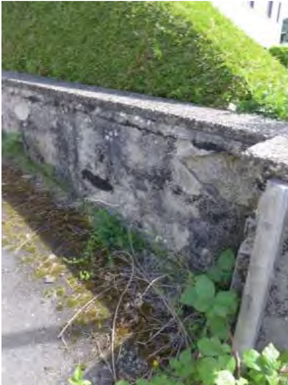
13 a Zustand Einfriedung
