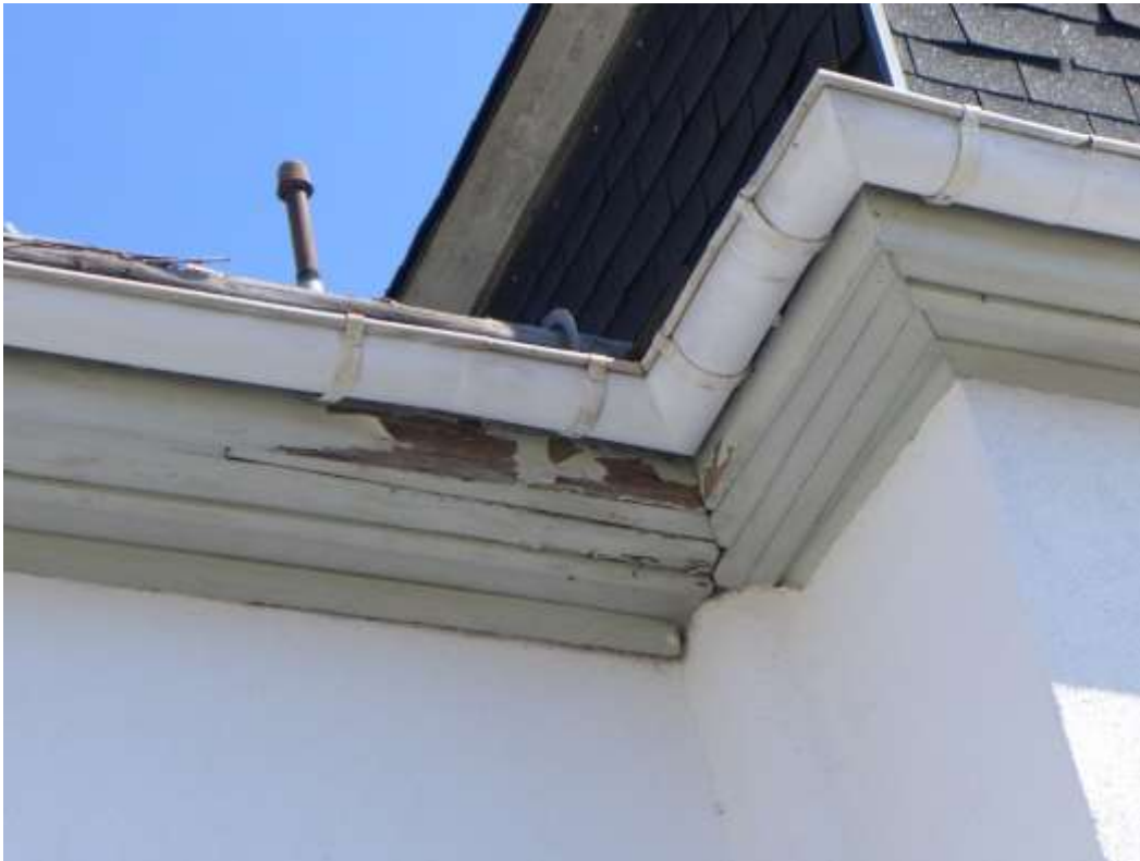
17 Schäden Dachrand
