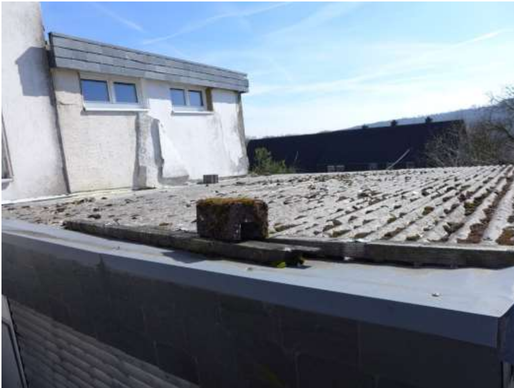
13 Dacheindeckung Garage, Fassade Anbau
