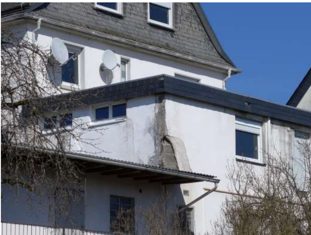
8 Fassadenschaden Anbau
