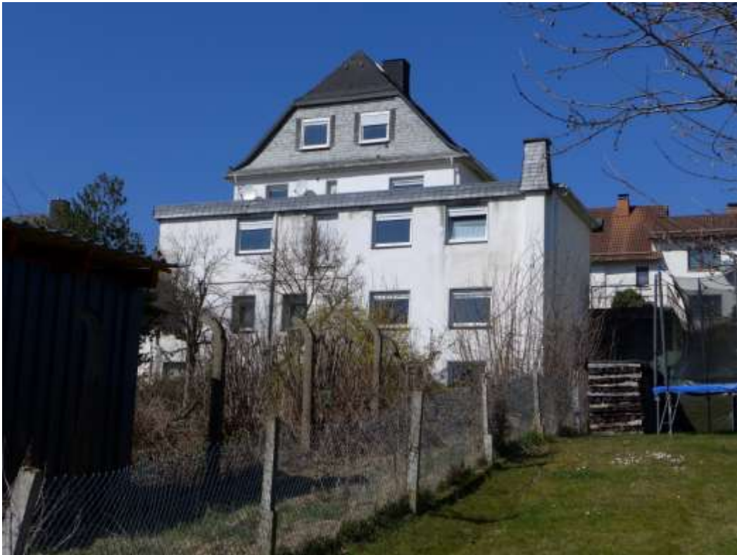
9 Rückansicht (Südostansicht) Anbau
