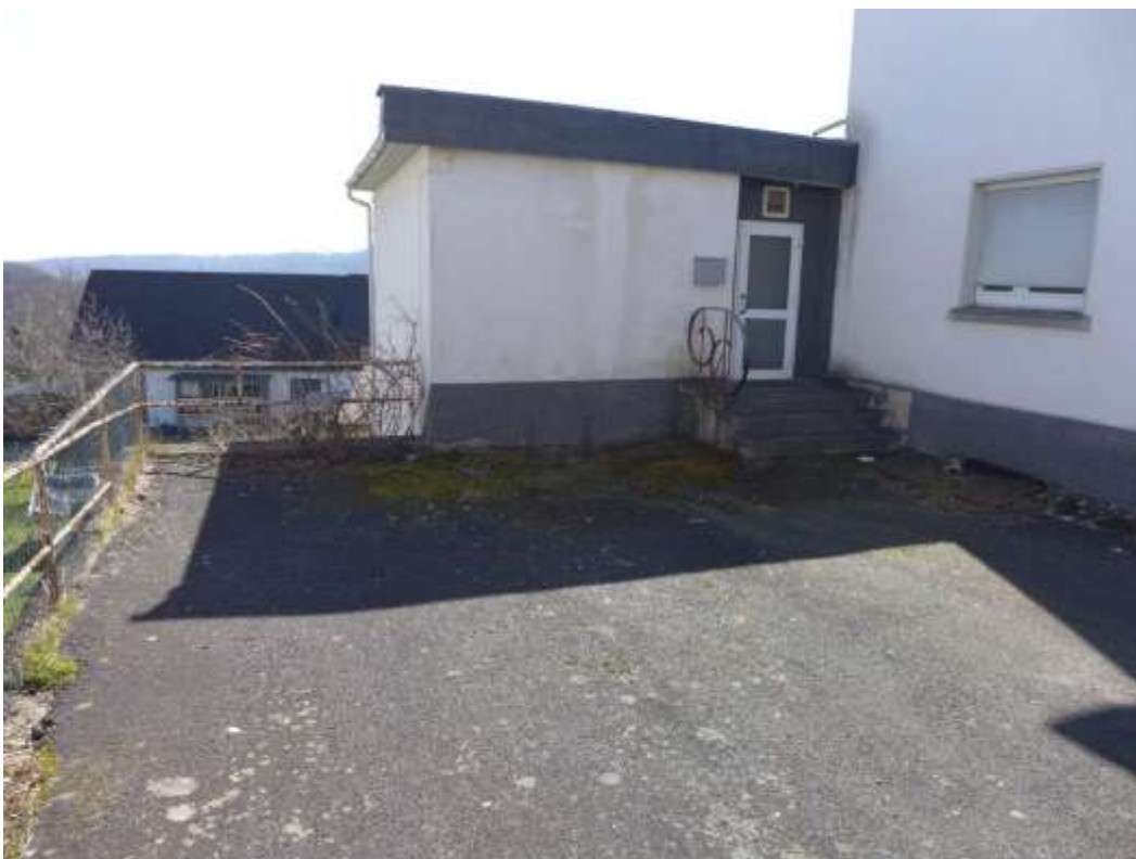
6 Stellplatzfläche, Eingang Anbau (Wohnheim)
