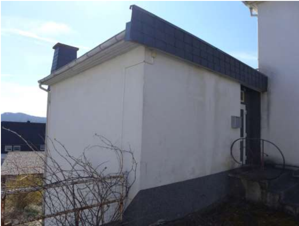
21 Anbau (ehemalige Backstube)
