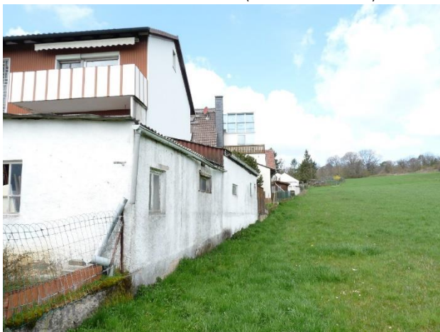
Foto 4 – Blick entlang der nordöstlichen Grundstücksgrenze
