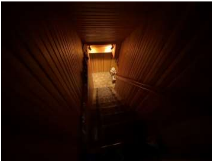
Bild 32: Treppe EG - KG
