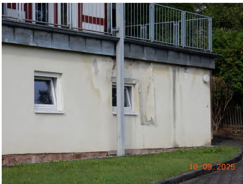
Feuchtigkeitsschaden Fassade
