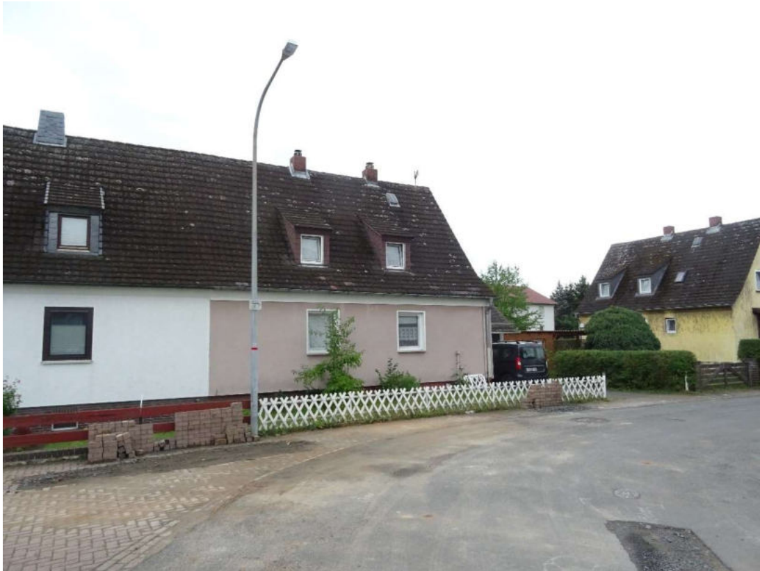
Abbildung 5: Doppelhaushälfte Ansicht von Nord-Westen
