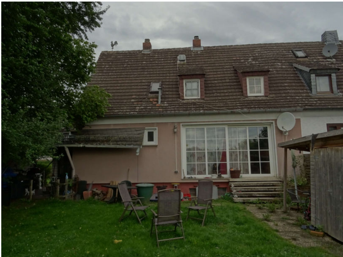
Abbildung 6: Wohnhaus Ansicht von Süd- Osten
