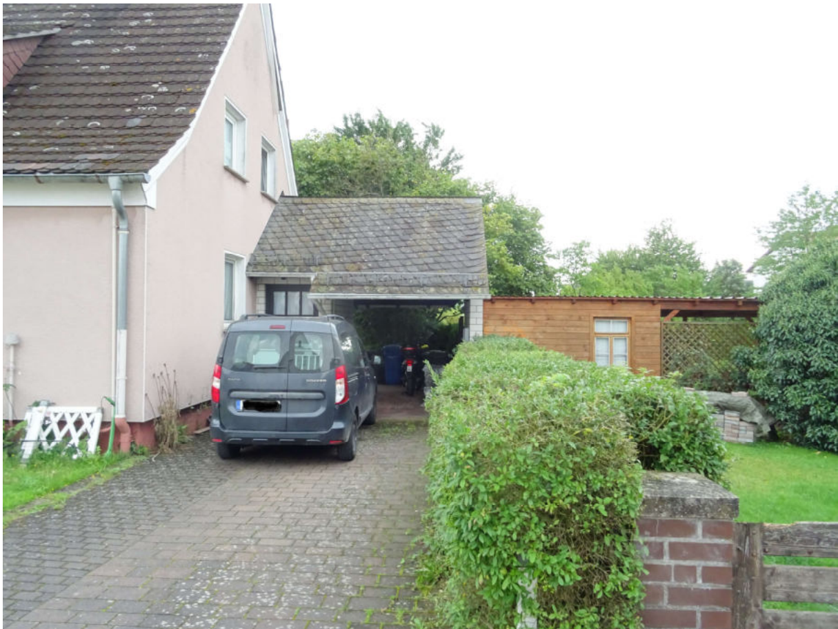
Abbildung 7: Carport Ansicht von Westen
