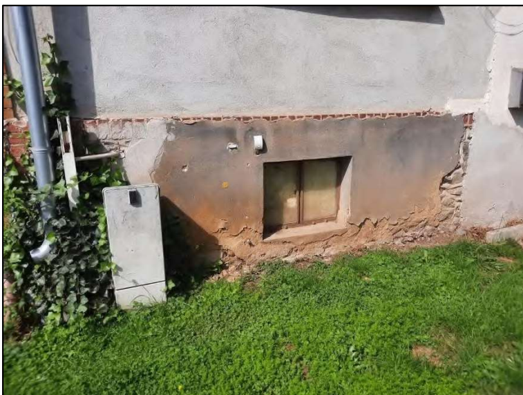
Abb. 15: Putzschäden im Sockelbereich
