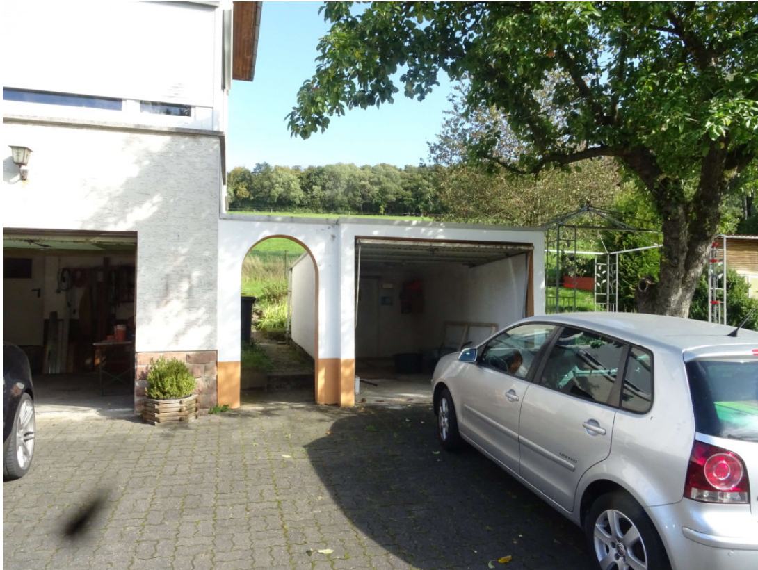
Abbildung 7: Garage Ansicht von Westen
