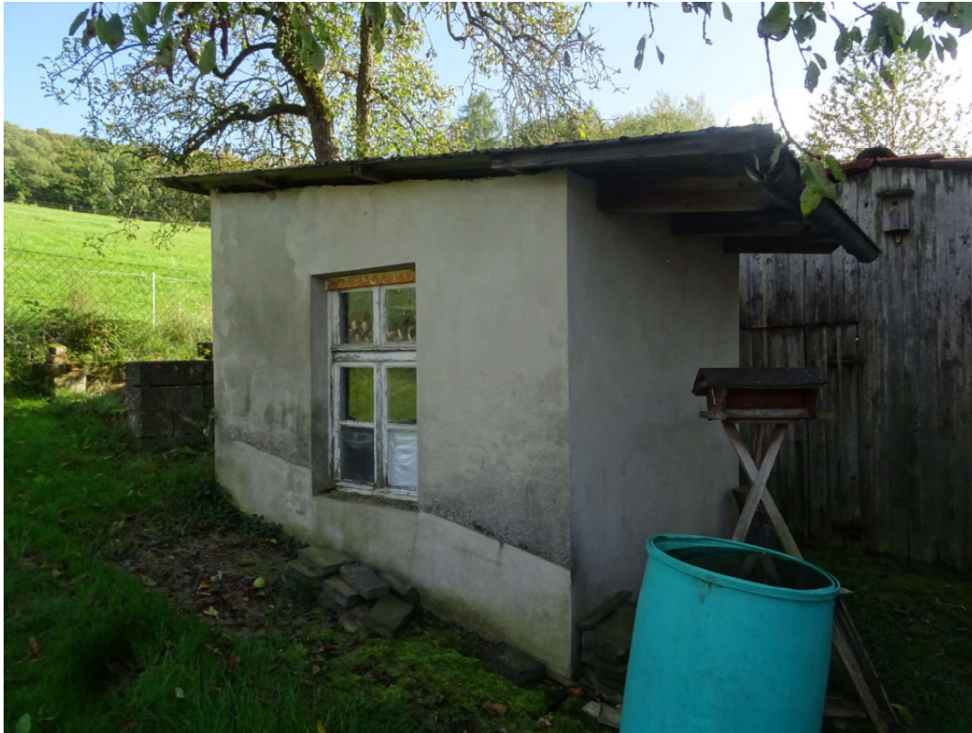
Abbildung 9 Schuppen Ansicht von Nordwesten
