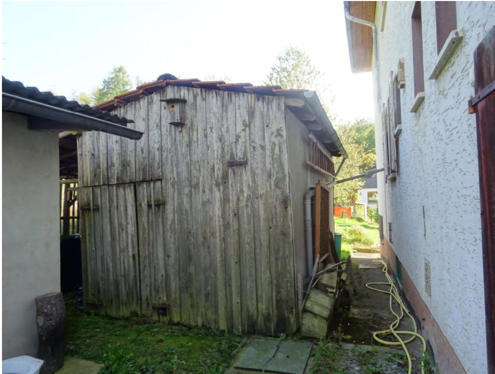
Abbildung 10 Holzschuppen Ansicht von Norden
