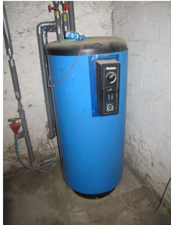
Warmwasserspeicher
