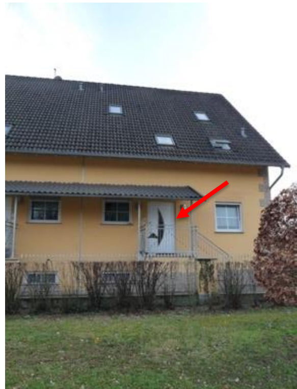
Hauseingang 9a / Nordseite
