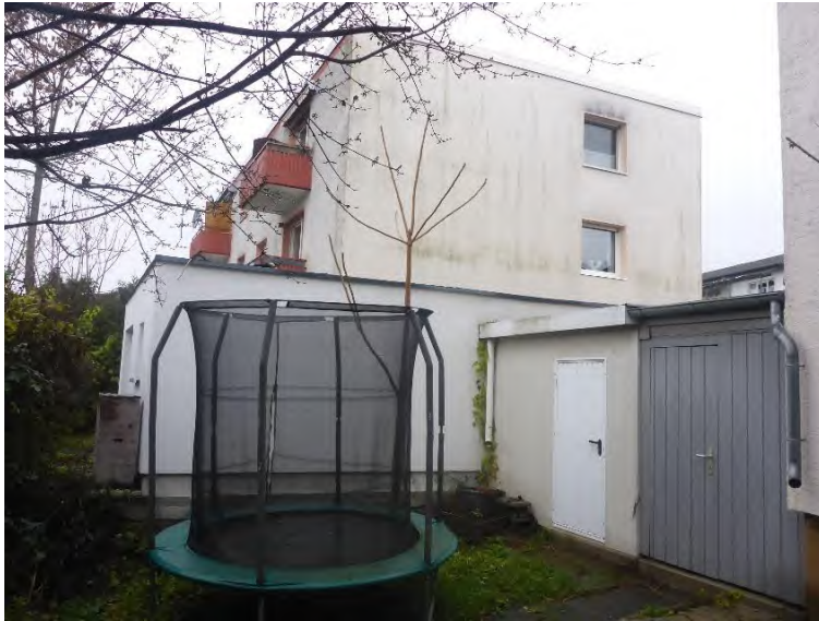
MFH - Ansicht von Süden
