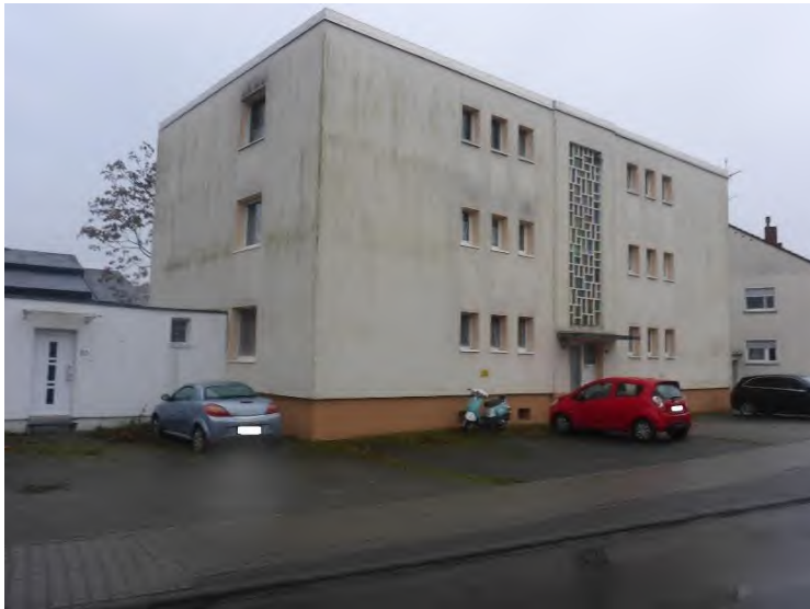
MFH - Ansicht von Nordosten
