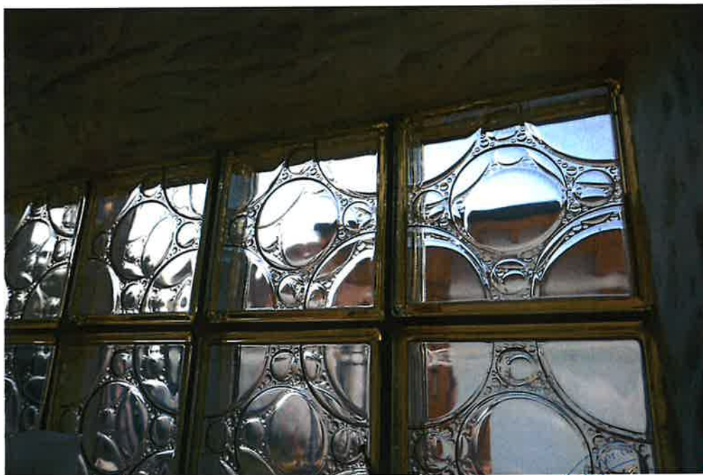
Bild 15: Glasbausteinfenster in der Brandwand Nord/West, fachgerecht zu verschliessen
