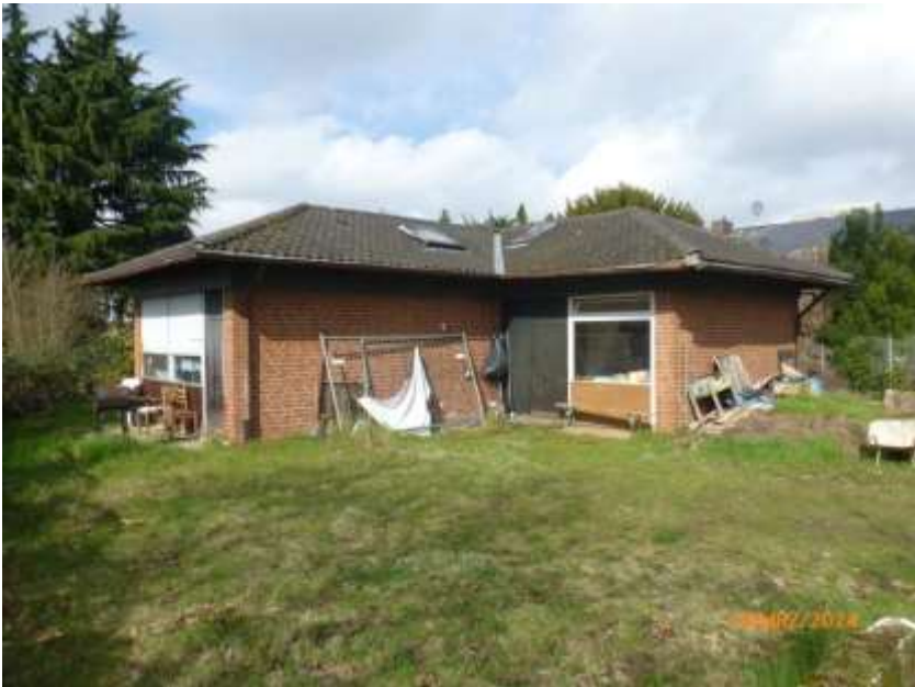
Ansicht von Süd-Osten, Gebäudebestand
