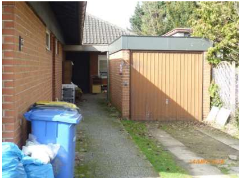
Ansicht von Osten, Gebäudebestand
