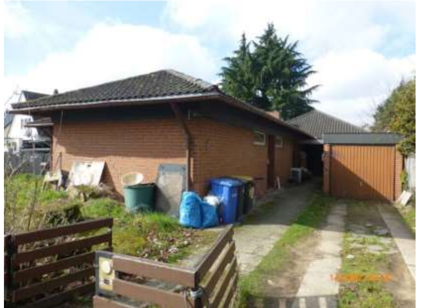
Ansicht von Osten, Gebäudebestand
