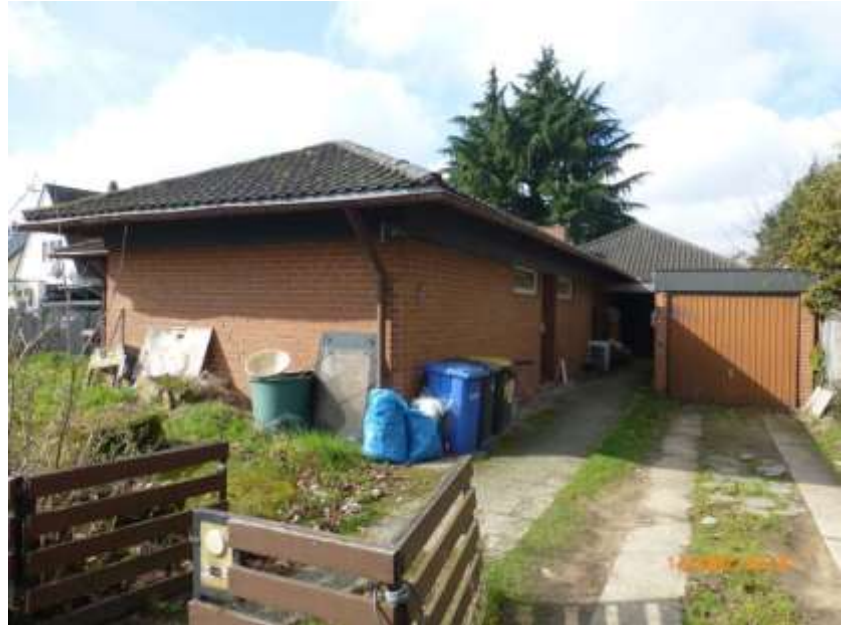
Ansicht von Osten, Gebäudebestand
