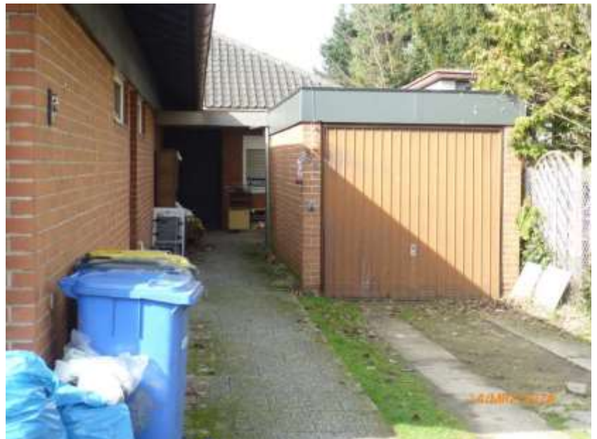
Ansicht von Osten, Gebäudebestand
