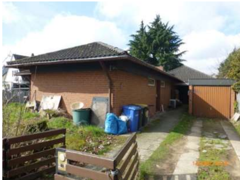
Ansicht von Osten, Gebäudebestand
