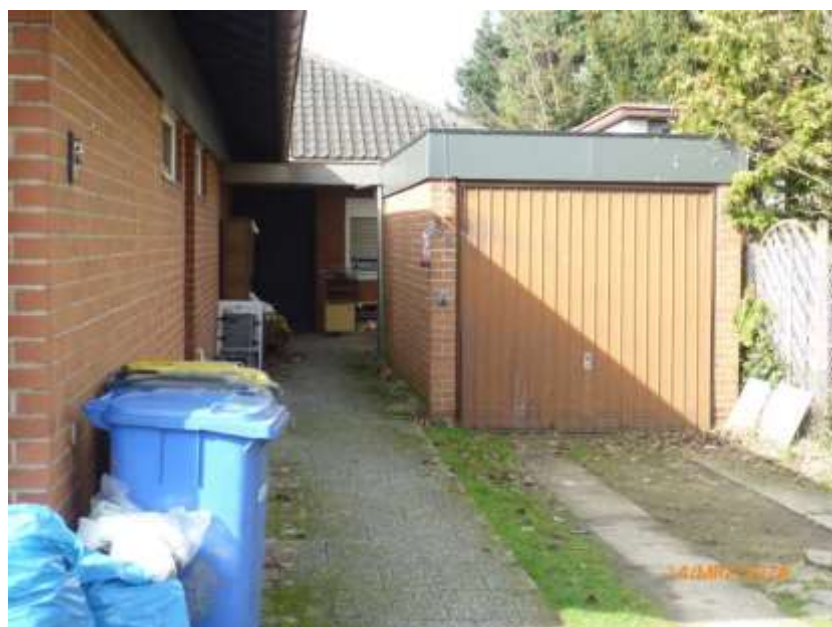
Ansicht von Osten, Gebäudebestand
