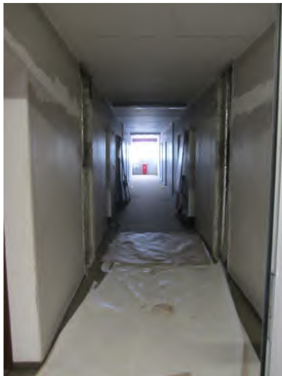
Bild 30: Flurbereich 1. OG (Sanierung Steigleitungen)
