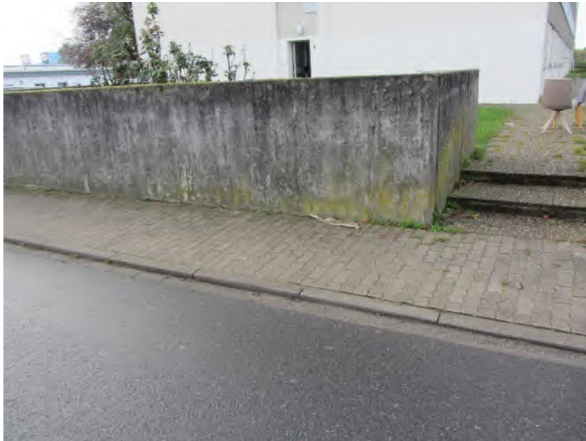
Bild 19: Einfriedung mit Betonmauer
