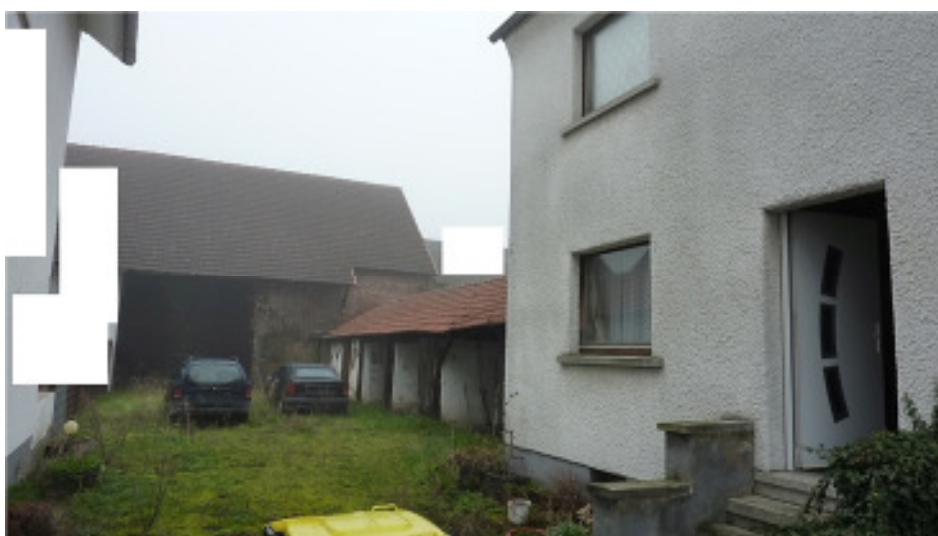
Hauseingang / überalterter Anbau / Scheune-Teilbereich stark vermooster Hofbereich
