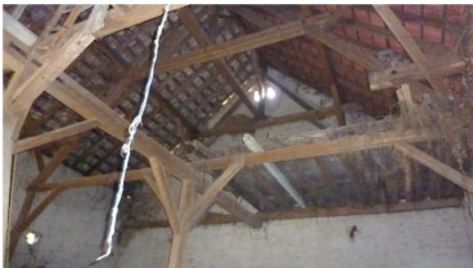
Scheune hoher Dachraum
