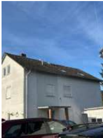
Ansicht Nordost / Dacheindeckung
