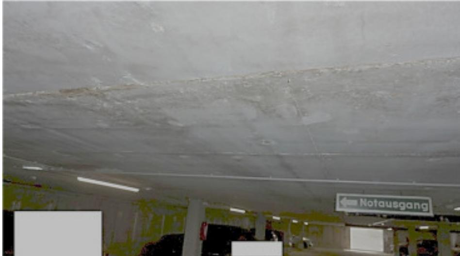
Deckenansicht Tiefgarage mit älteren partiellen Feuchtschäden
