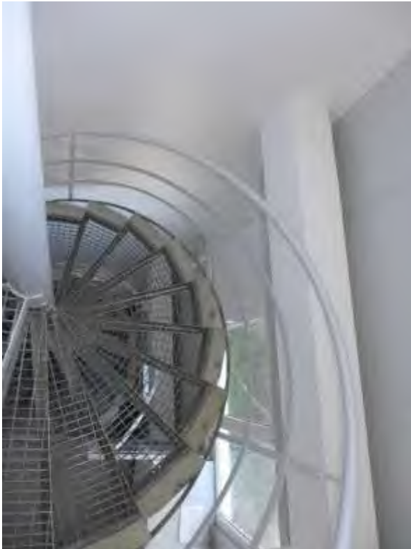
23 a Treppe zum 1. Obergeschoss
