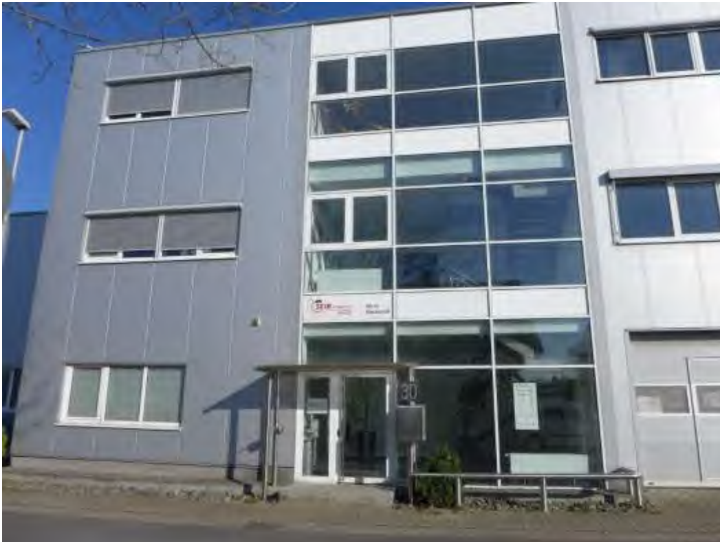
5 Nordwestansicht Verwaltungsgebäude, kleine Halle
