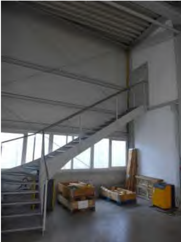
33 Zugang von Halle zum Besprechungsraum
