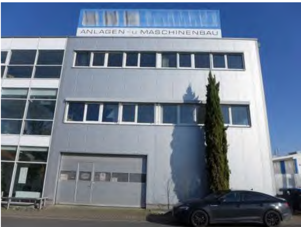
6 Nordwestansicht Verwaltungsgebäude, kleine Halle
