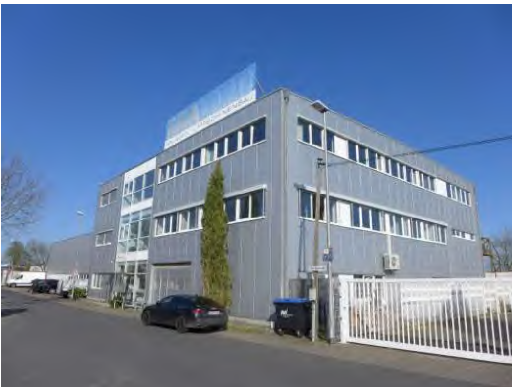
4 Südwestansicht Verwaltungsgebäude, kleine Halle
