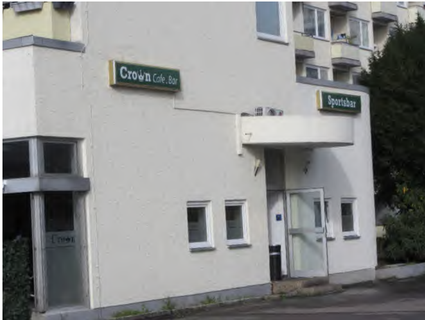
Bild 11: Restaurant/ Gastro/ Bistro im Erdgeschoss
