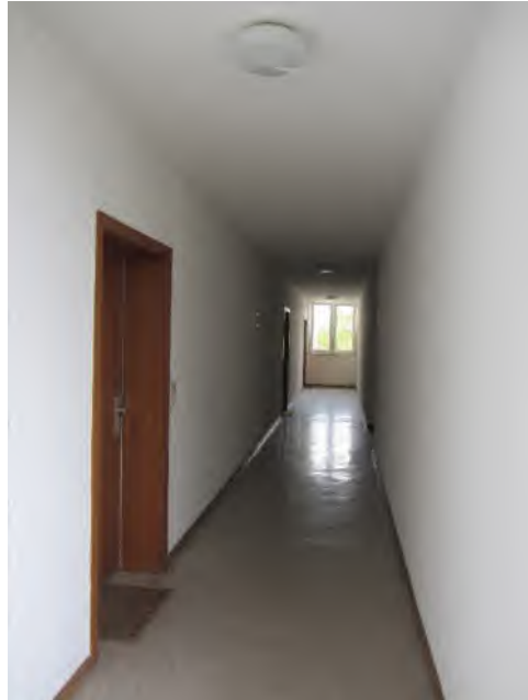
Bild 23: Flurbereich vor Wohnung 182
