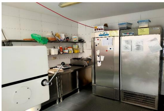
Küche im EG Nebengebäude
