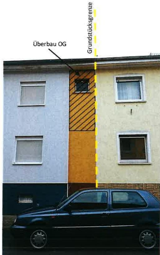
Bild 3: Der braune Streifen zwischen den Gebäuden markiert im OG den Überbau, im EG ist dieser Bereich dem Nachbargrundstück 219/2 zugehörig (siehe auch amtl. Lageplan)
