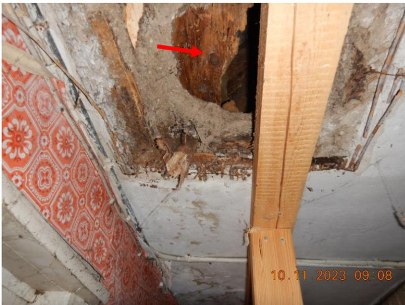
Im Bereich der Wand ist ein Teil der beschädigten Holzkonstruktion zu sehen, Bild 13.
