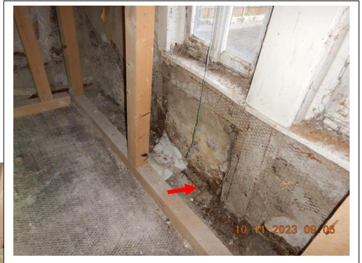
Im Erdgeschoß wird die Decke abgestützt, Bilder 6 und 7.
