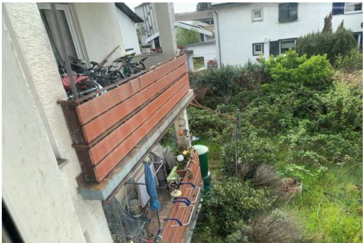
Ansicht der Balkone von Westen
