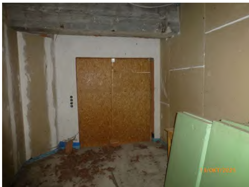
Innenansicht EG, Wohnhaus Anbau
