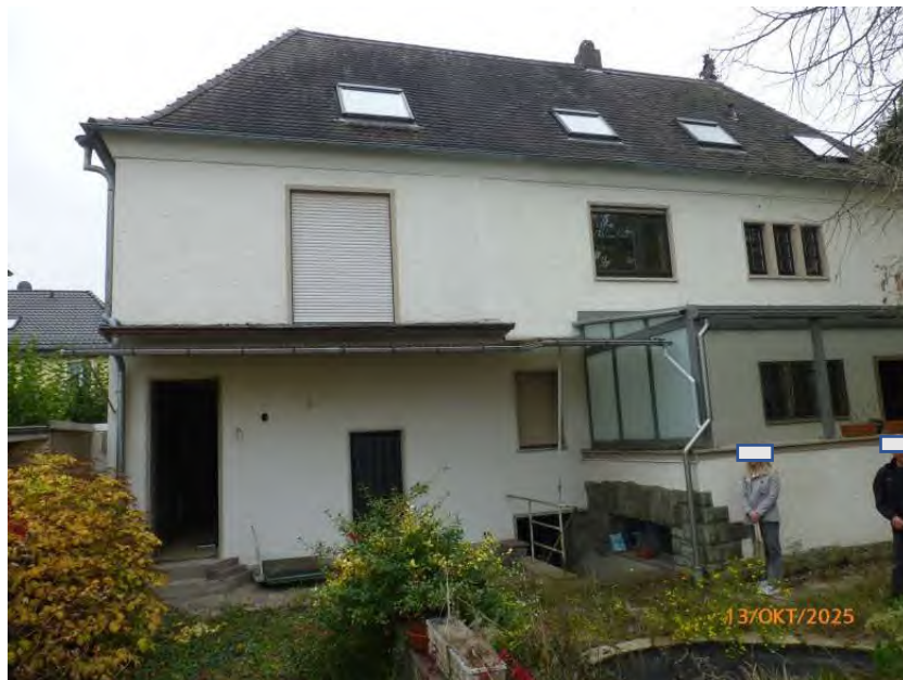
Ansicht von Norden, Wohnhaus
