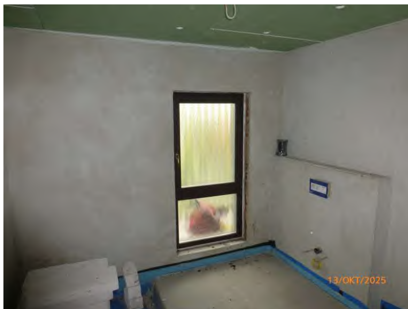
Innenansicht EG, Wohnhaus Anbau
