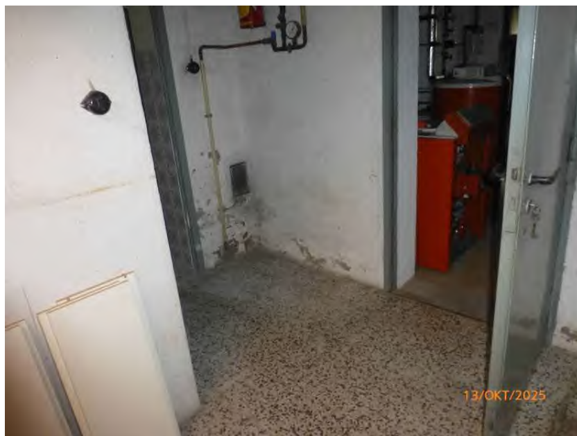
Innenansicht KG, Wohnhaus
