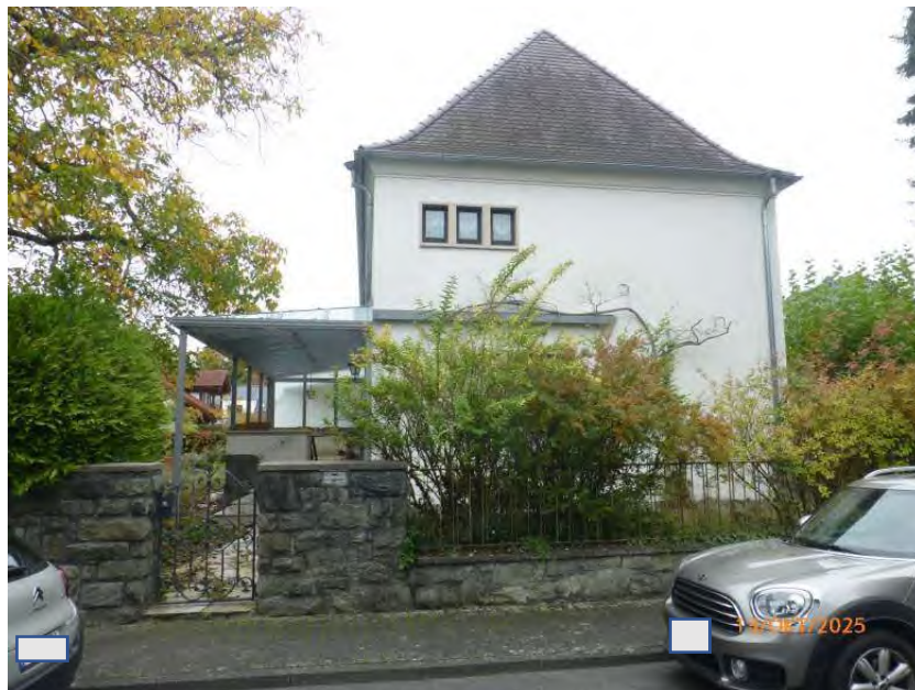
Ansicht von Westen, Wohnhaus
