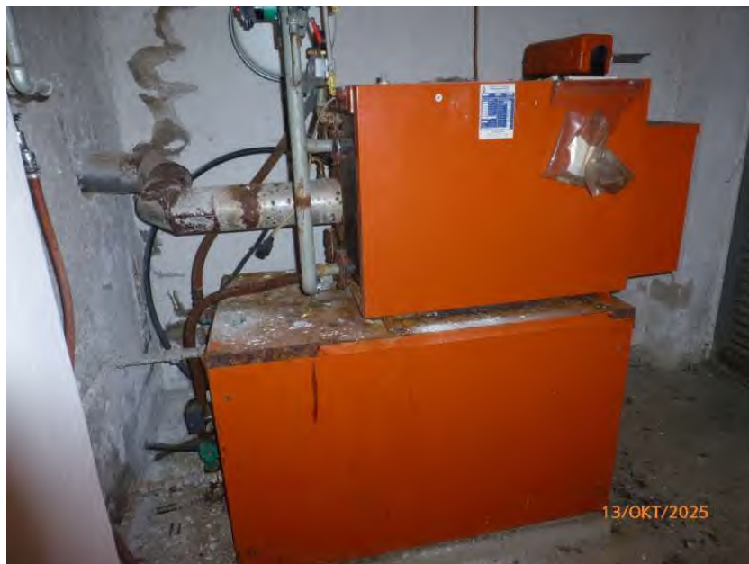
Innenansicht KG, Gewerbebau
