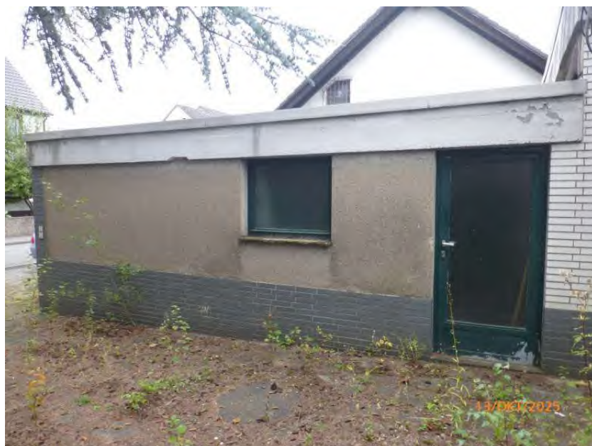
Ansicht von Süden, Garage
