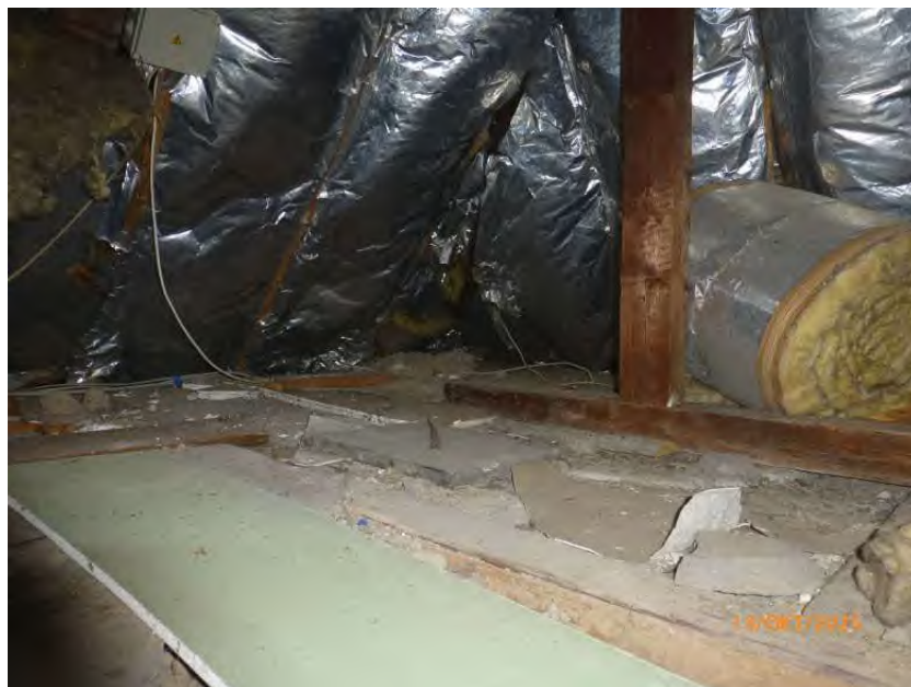
Innenansicht Dachraum, Wohnhaus
