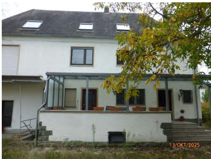
Ansicht von Norden, Wohnhaus
