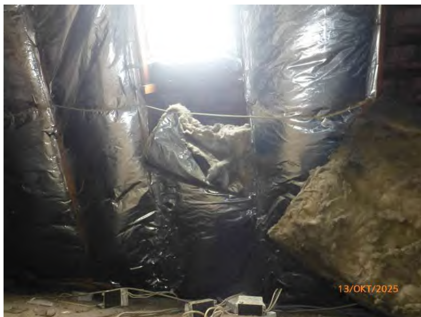
Innenansicht Dachraum, Wohnhaus
