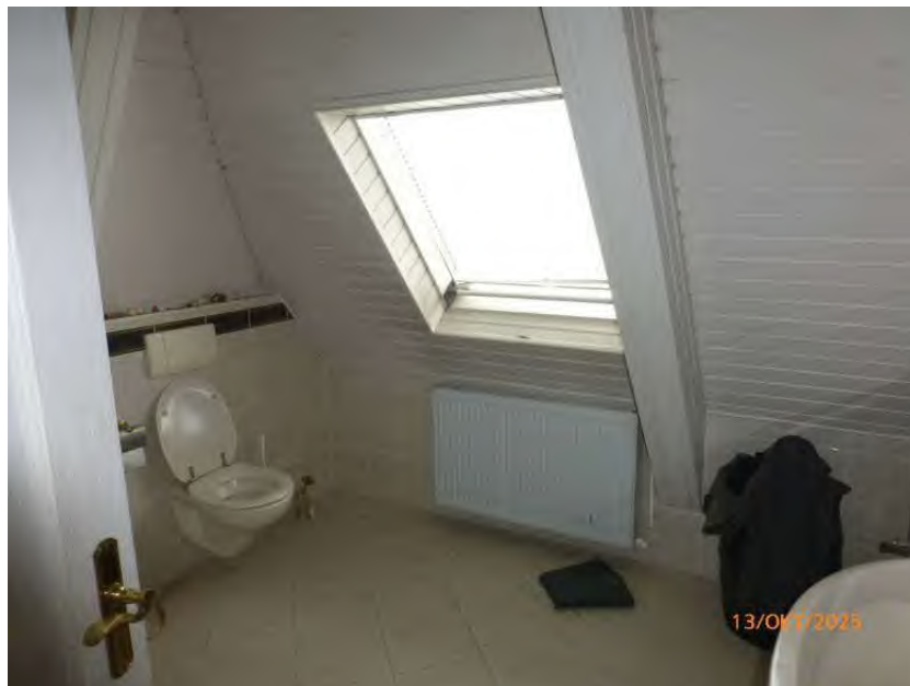
Innenansicht DG, Wohnhaus
