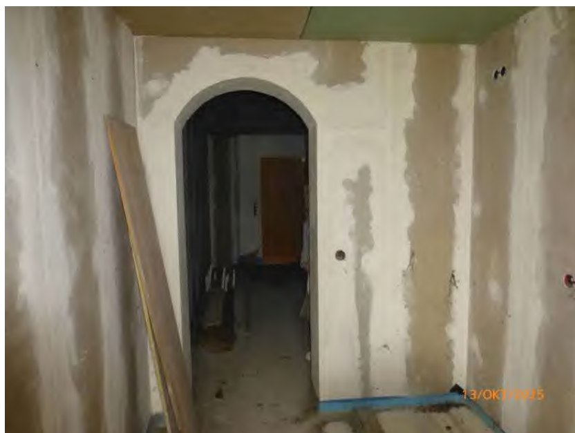
Innenansicht EG, Wohnhaus Anbau
