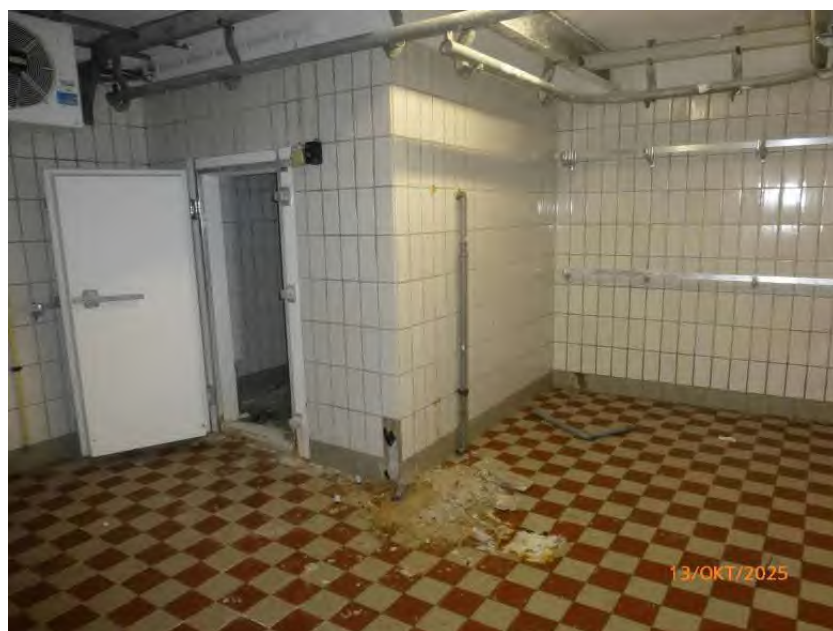
Innenansicht EG, Gewerbebau
