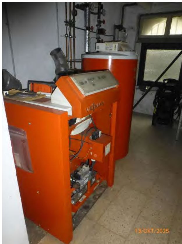
Innenansicht KG, Wohnhaus
