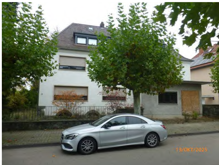
Ansicht von Süden, Wohnhaus
