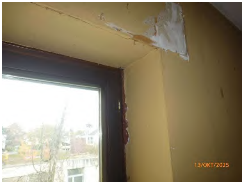
Innenansicht OG, Wohnhaus
