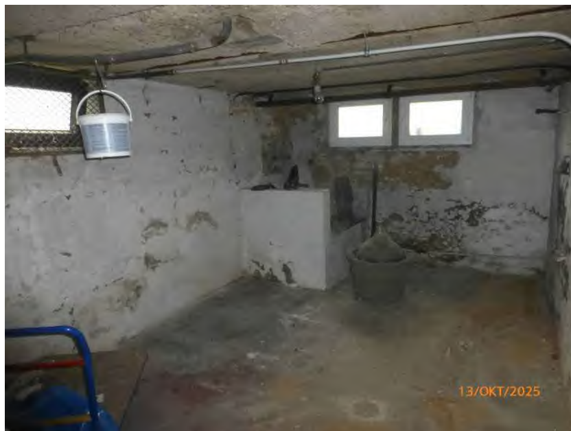
Innenansicht KG, Wohnhaus
