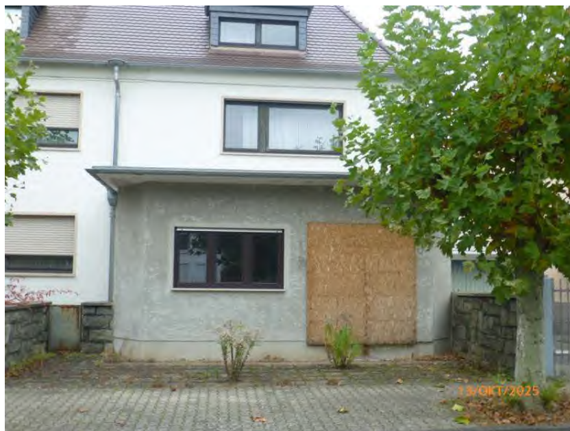
Ansicht von Süden, Wohnhaus
