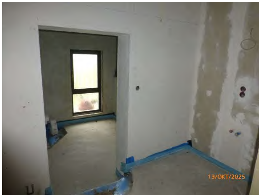
Innenansicht EG, Wohnhaus Anbau
